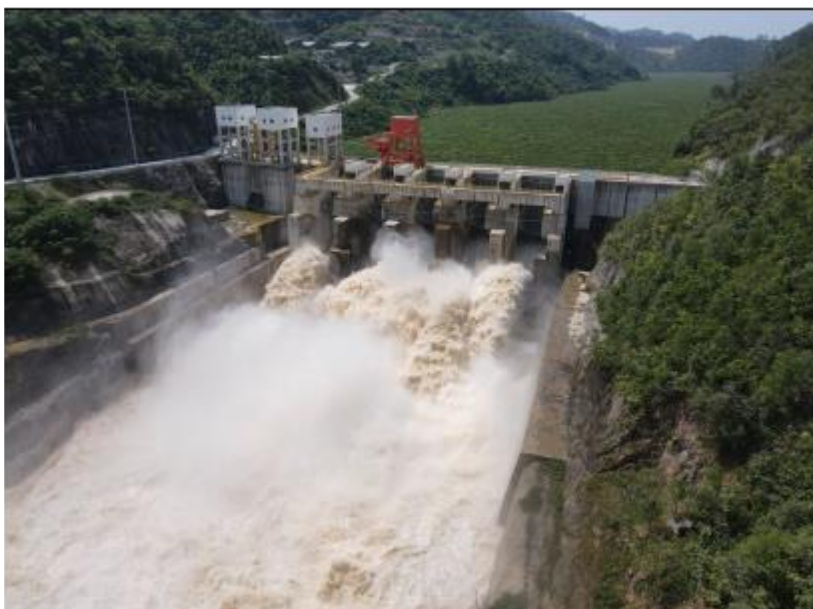
Ilustración 1: Vista aguas abajo del sitio de Presa
