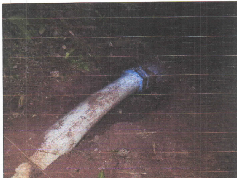
ACTIVIDAD – (fundición de concreto en codos de P.V.C)
