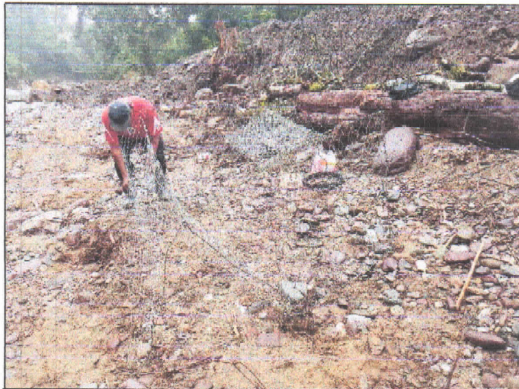
ACTIVIDAD – (Armado de Gaviones para refuerzo de estructura inferior de la cortina de concreto de la represa debido a daños ocasionados por las tormentas ETA e IOTA.)
