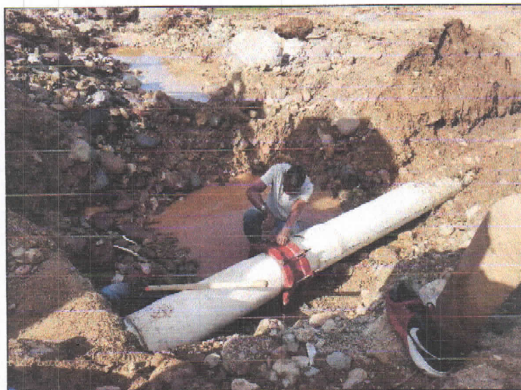
ACTIVIDAD. – (Reparación de junta Dress en línea de conducción de planta de filtros hacia tanque principal.)
