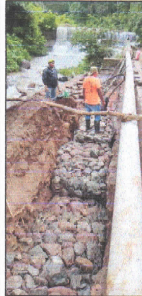
ACTIVIDAD – ( Instalación de Gaviones con piedra de río para protección de tubería de 10 Pulgadas y pilas de filtración, previo a la tormenta tropical ETA.).
