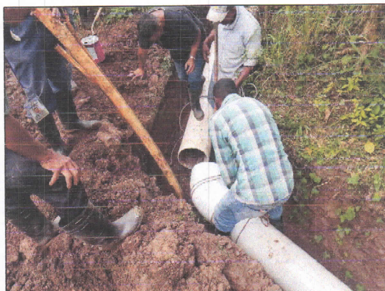
ACTIVIDAD - (Instalacion de tubos y accesorios P.V.C de 12 Pulgadas.)
