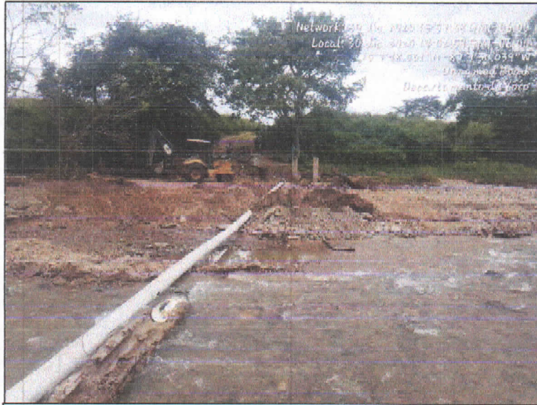
ACTIVIDAD. – (Repacion de tubería P.V.C de 10 pulgadas en línea que conduce hacia las Colonias, Reino Unido, Rafael Diaz Chavez, Porfirio Martinez y Santa Lucía)
