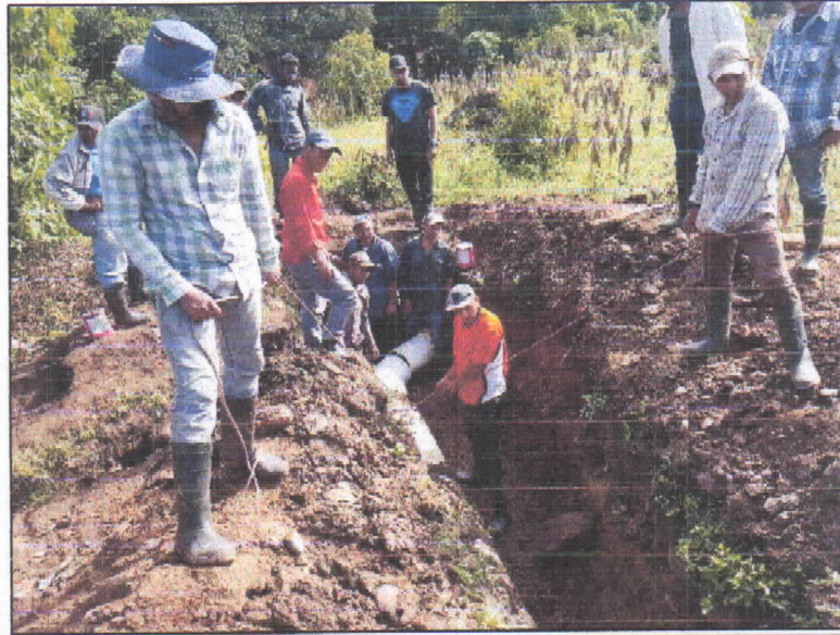
ACTIVIDAD (Instalación de tubos y accesorios P.V.C de 12 Pulgadas).
