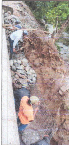
ACTIVIDAD – ( Instalación de Gaviones con piedra de río para protección de tubería de 10 Pulgadas y pilas de filtración, previo a la tormenta tropical ETA.).
