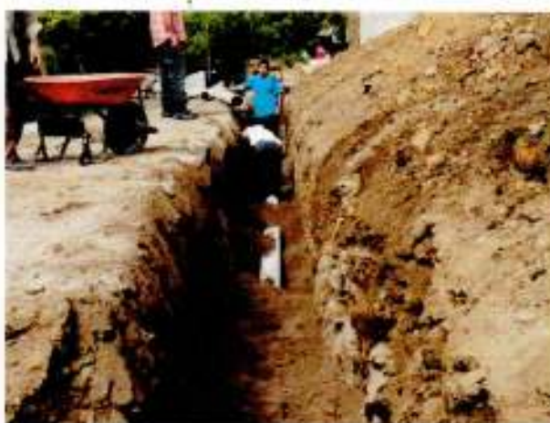
Instalación y soterrado de Tubería principal
