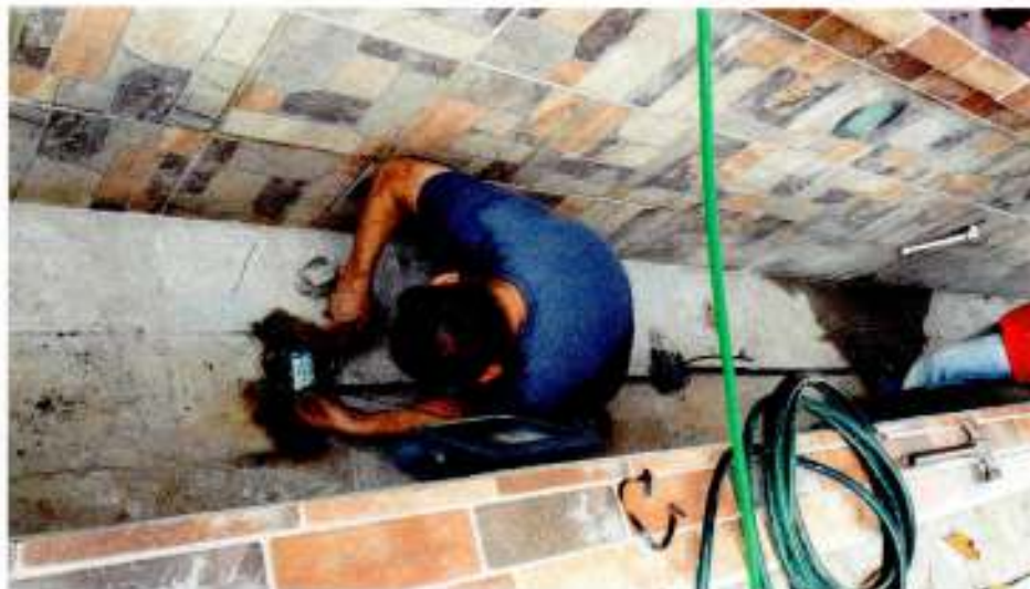
Instalación de conducto eléctrico para luces.
