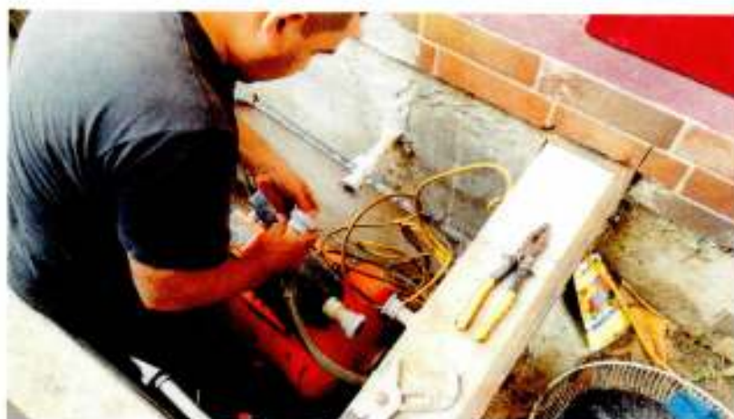
Desmontaje de bomba Hidroneumática
