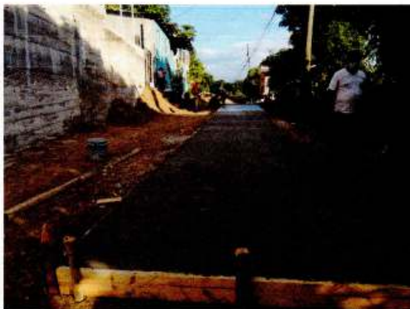
Construcción de Pavimento con Concreto Hidráulico 4,000 PSI
