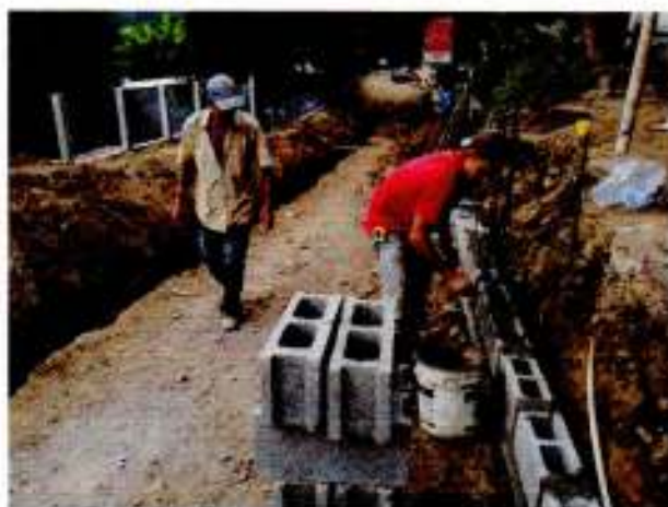
Construcción de muro de contención con bloque reforzado
