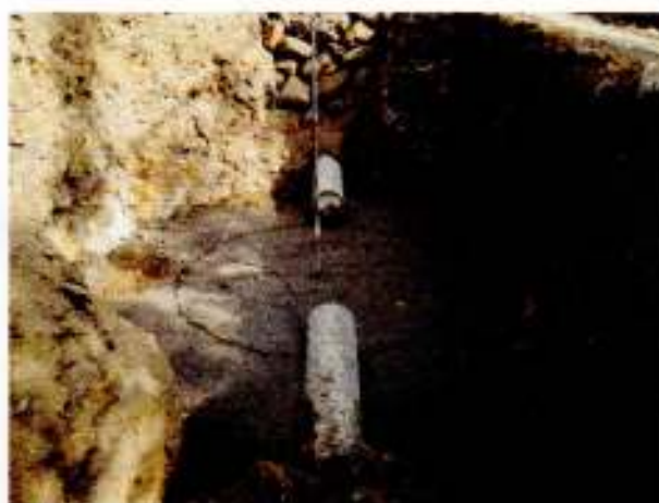
Construcción de Pozo de inspección
