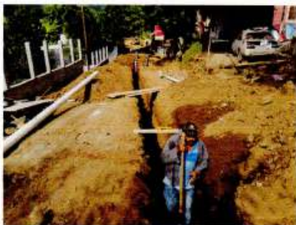
Instalación y soterrado de Tubería principal
