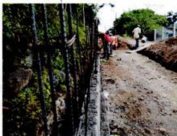
Construcción de muro de contención con bloque reforzado
