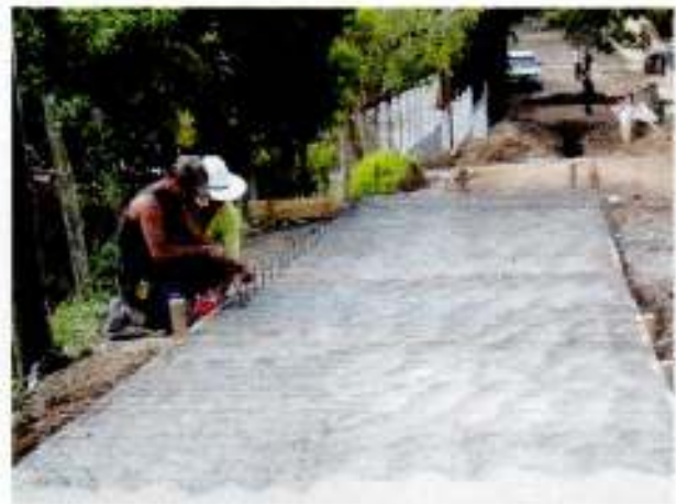
Construcción de Pavimento con Concreto Hidráulico 4,000 PSI
