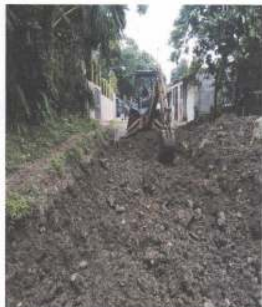
Conformación de Subrasante y perfilado de la calle
