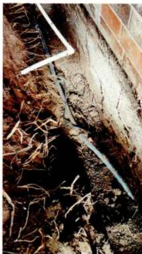
Retiro de instalación eléctrica no adecuada.
