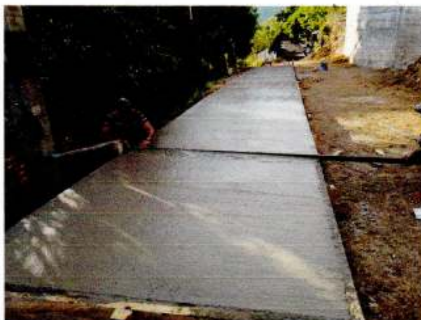
Construcción de Pavimento con Concreto Hidráulico 4,000 PSI
