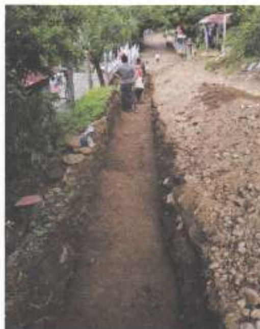
Excavación/zanjeo para construcción de muro de contención.
