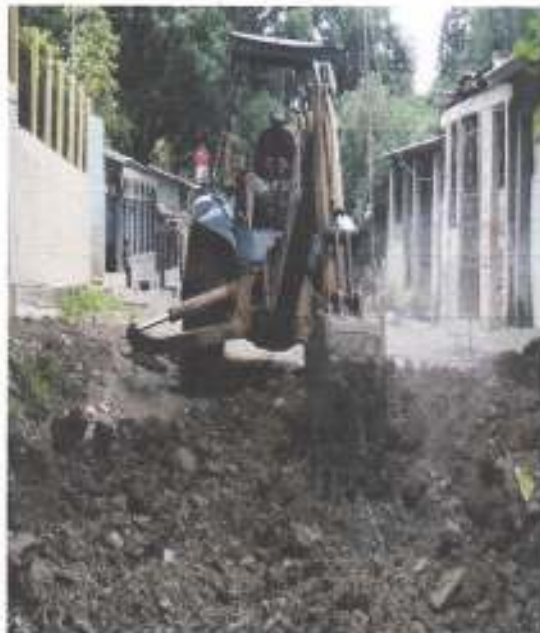
Conformación de Subrasante y perfilado de la calle
