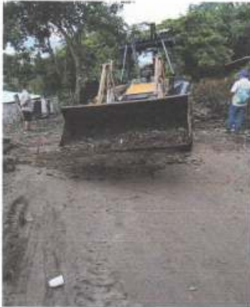
Conformación de Subrasante y perfilado de la calle
