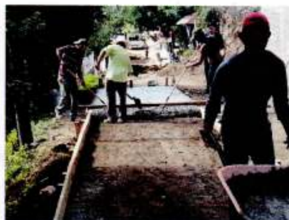
Construcción de Pavimento con Concreto Hidráulico 4,000 PSI
