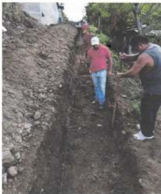
Excavación/zanjeo para construcción de muro de contención.
