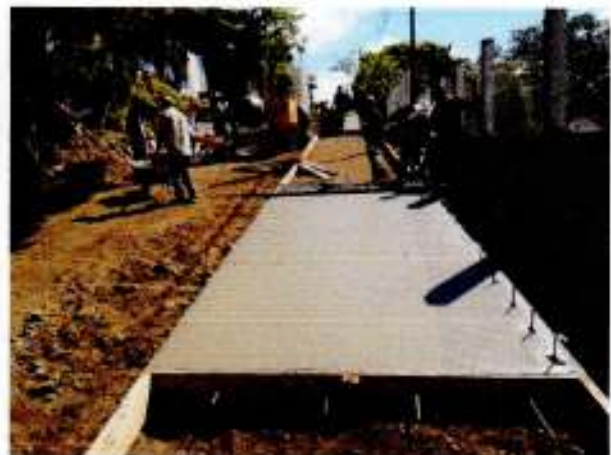
Construcción de Pavimento con Concreto Hidráulico 4,000 PSI
