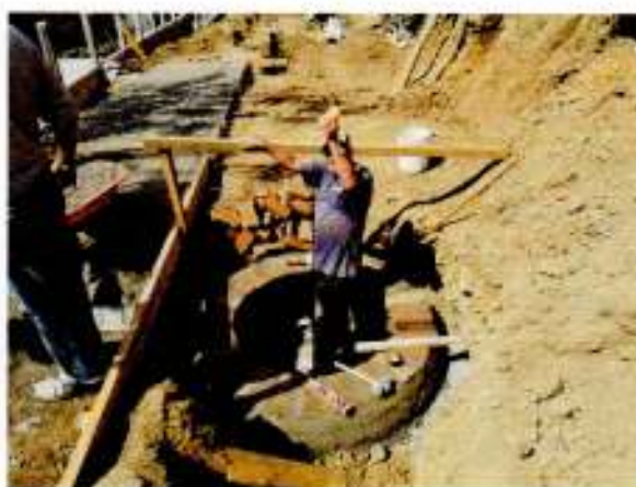
Construcción de Pozos de Inspección
