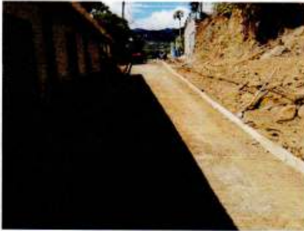
Construcción de Pavimento con Concreto Hidráulico 4,000 PSI
