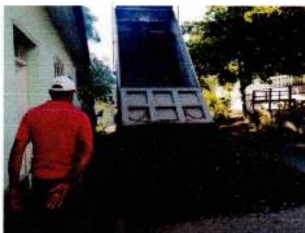
Suministro de materiales: Grava
