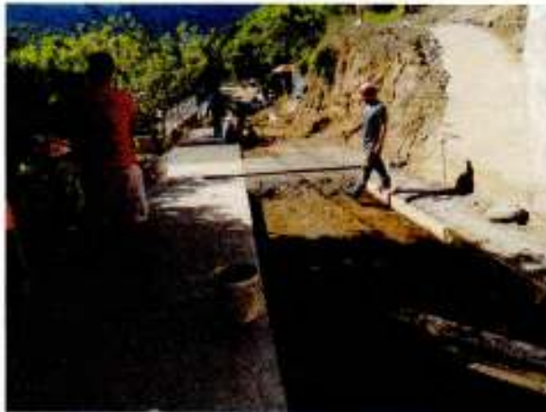
Construcción de Pavimento con Concreto Hidráulico 4,000 PSI
