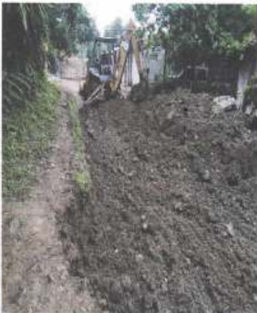
Conformación de Subrasante y perfilado de la calle
