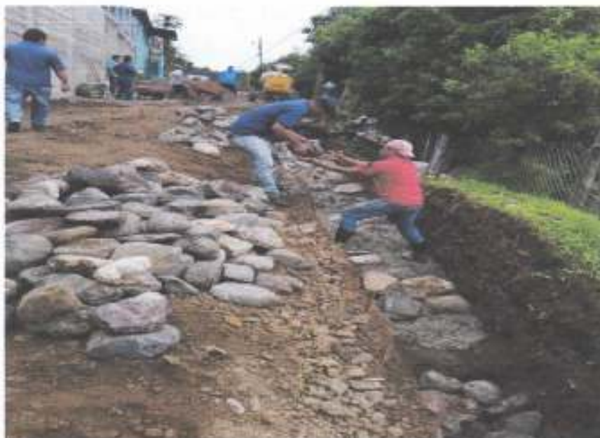
Construcción de muro de contención de concreto ciclopeo
