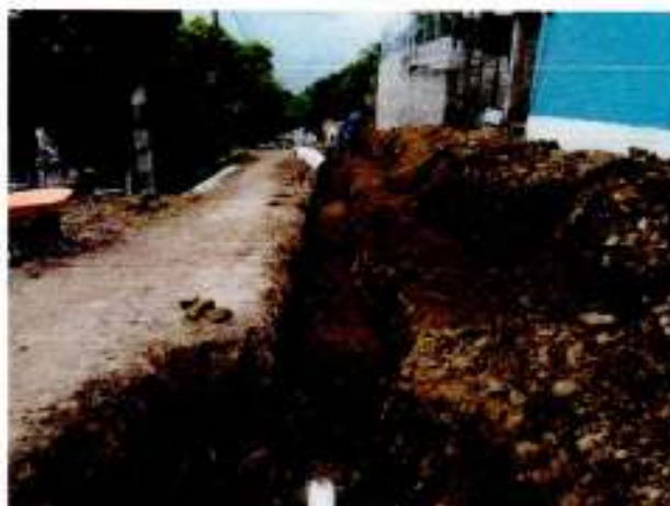
Instalación de Tubería de 6" para Alcantarillado Sanitario
