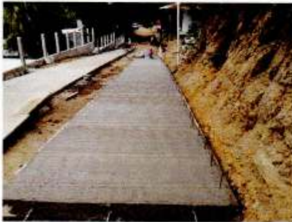
Construcción de Pavimento con Concreto Hidráulico 4,000 PSI
