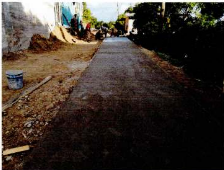
Construcción de Pavimento con Concreto Hidráulico 4,000 PSI
