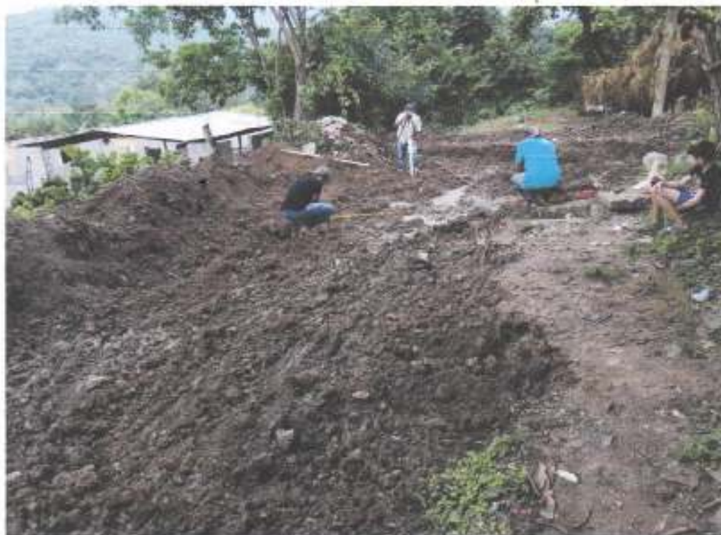
Actividades de Replanteo con equipo de topografía
