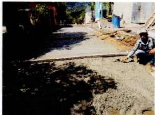
Construcción de Pavimento con Concreto Hidráulico 4,000 PSI
