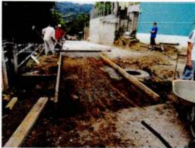
Construcción de Pavimento con Concreto Hidráulico 4,000 PSI
