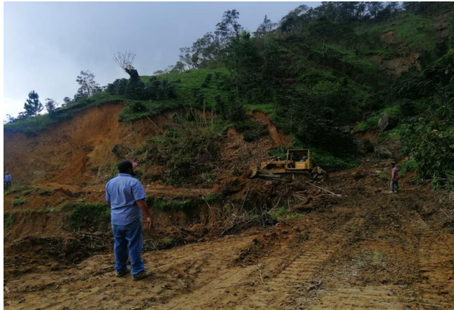
TRABAJOS DE CANALIZACION DE RIO, COMUNIDAD DE CANGELICA ABAJO
