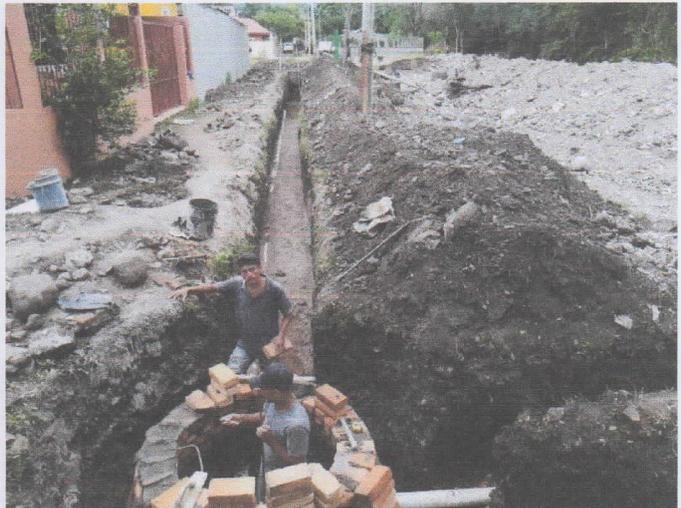
*Construcción de Pozo de Inspección #3*
