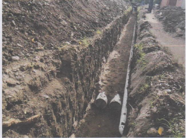
*Colocación de Capa de Limo sobre tubería*
