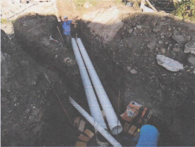
*Instalación de tubería de Drenaje de Aguas Negras*
