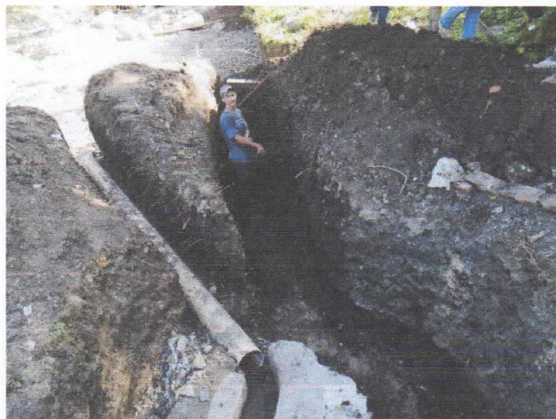
Conformación de zanjas
