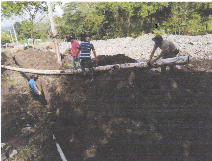
Desinstalación de tubería
