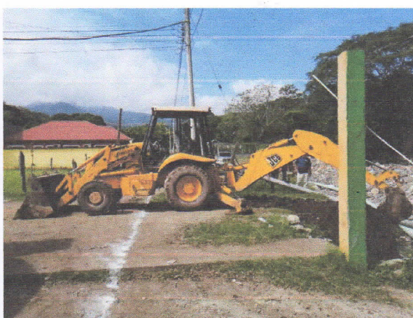
Apertura de Zanjas para desinstalación y limpieza de tubería
