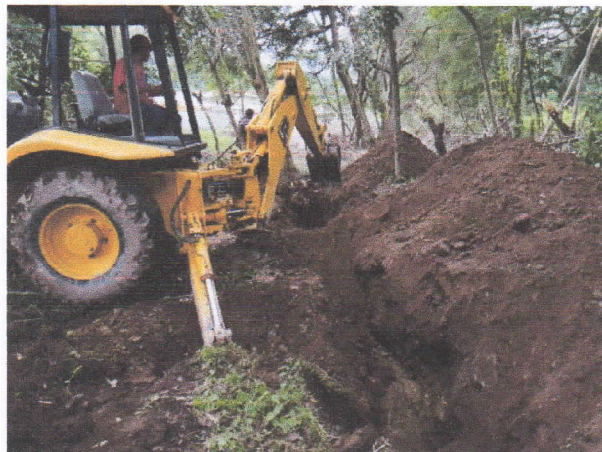
Apertura de Zanjas para desinstalación y limpieza de tubería
