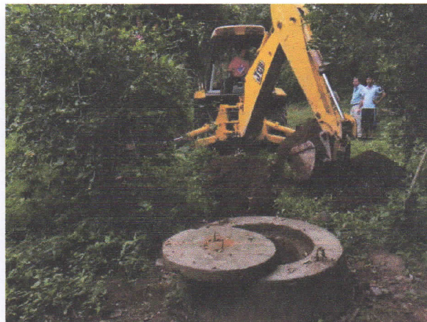
Apertura de Zanjas para desinstalación y limpieza de tubería
