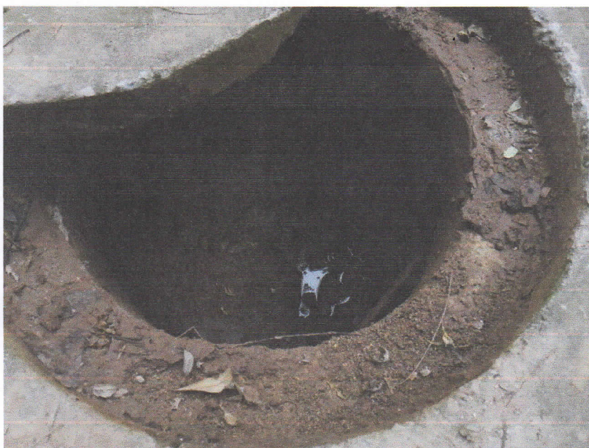
Limpieza de Pozo de Inspección
