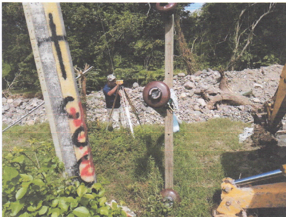
Replanteo con equipo de Totografía
