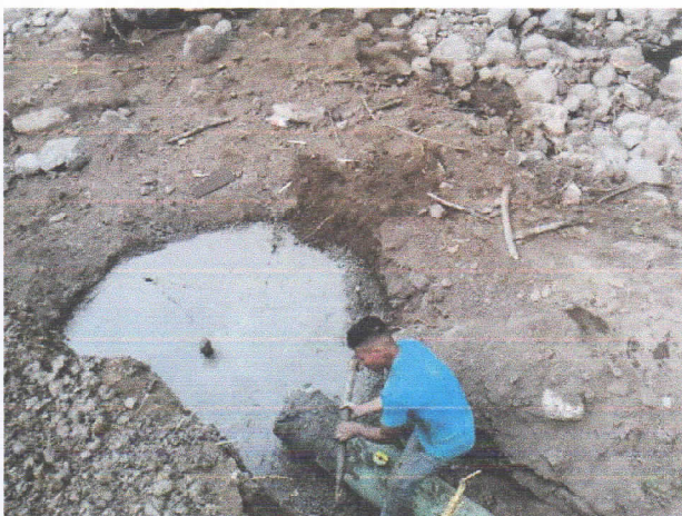
Construcción de Base para Pozo de inspección
