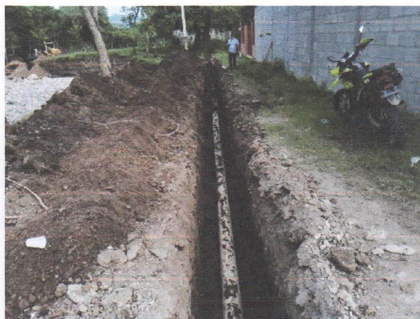
Excavación de Zanjas para desinstalación y limpieza de tubería de Aguas Negras existente.
