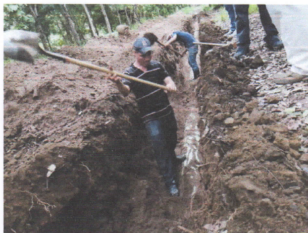
Excavación de Zanjas para desinstalación y limpieza de tubería de Aguas Negras existente.
