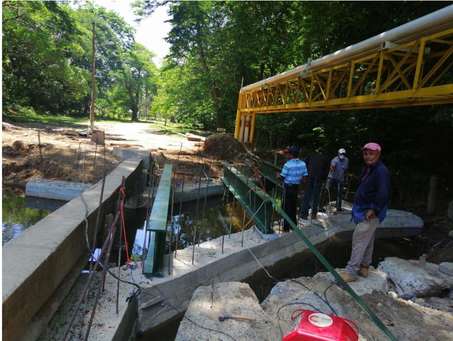
Ilustracion1. Instalación de Vigas Metálicas.
