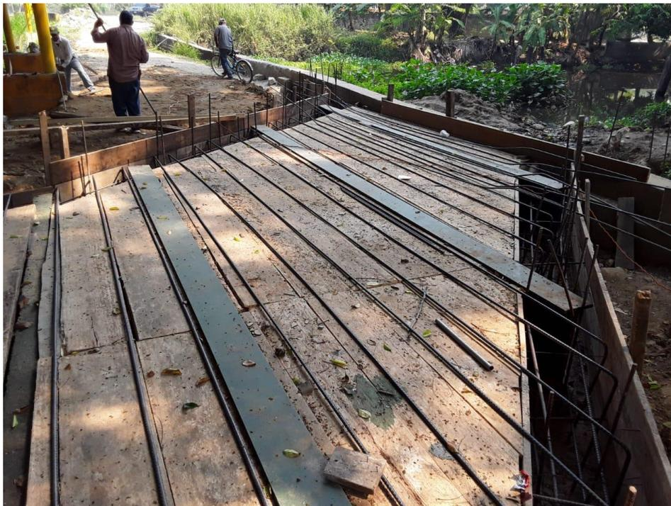
Ilustracion2. Preparación y encofrado para la fundición de la losa de concreto.
