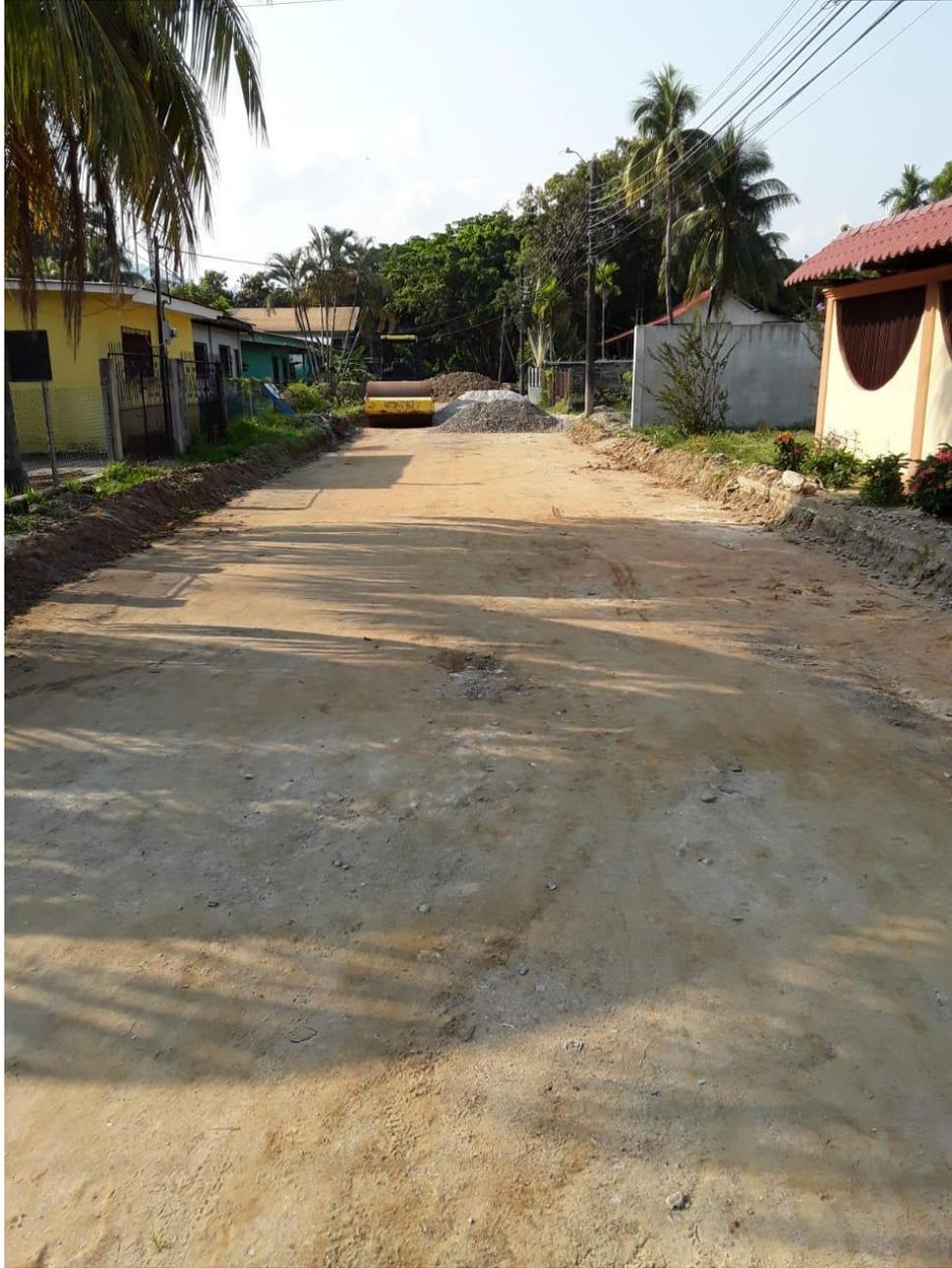
Ilustracion3. Corte y nivelación del terreno Pavimentación fase2.
