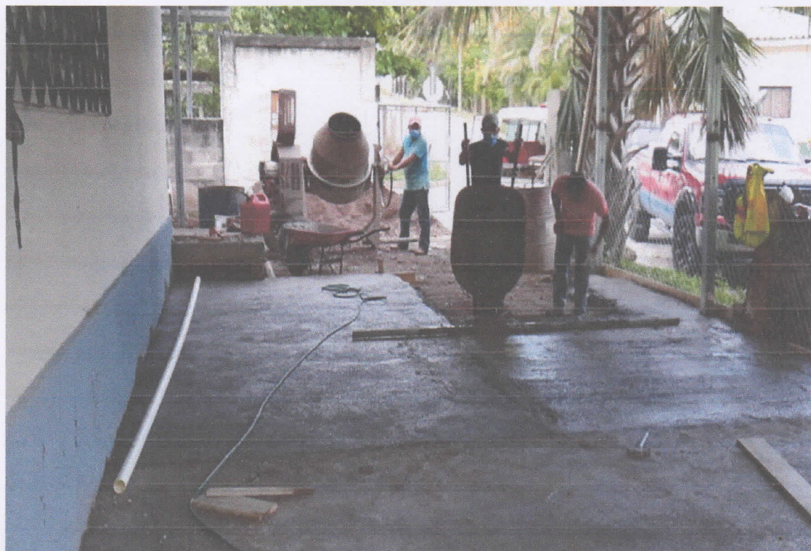
PISOS DE LA GALERA EN CLINICA DE EMERGENCIA PARA ATENCION EN EMERGENCIA COVID-19
