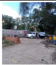
Avance Instalaciones Eléctricas: Instalación de Poste y transformador Pad Mounted
