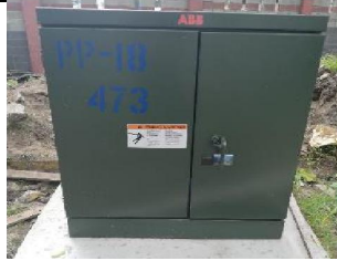
Avance Instalaciones Eléctricas: Instalación de Poste y transformador Pad Mounted
