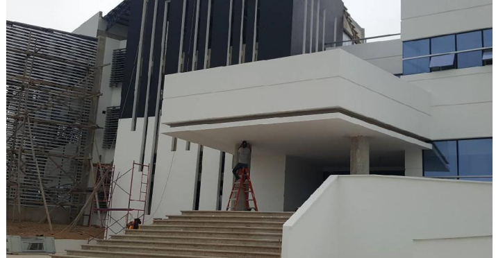
Avances fachada sur, edificio administrativo, aplicacion de pintura.
