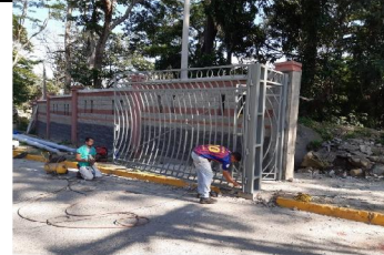
Instalación portón acceso Este vehicular principal
