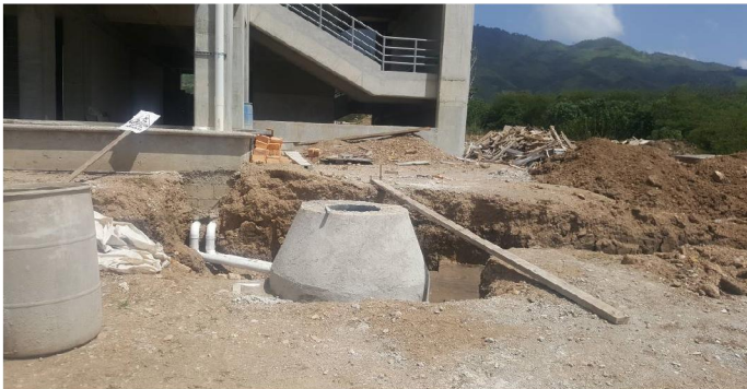
Pozo de aguas lluvias, Edificio Aulas No.1
