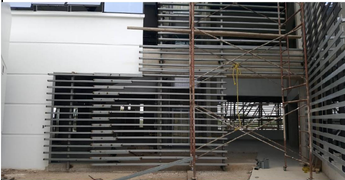
Avances en la instalacion de louvers en fachada norte, Edificio Administrativo
