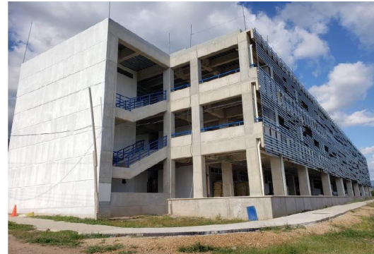
Edificio de Aulas No.1, fachada sur
