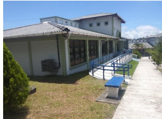
Fotografía No. 4. Edificio N°1
