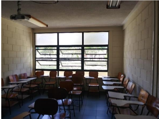
Fotografía N° 1. Aula en primer nivel del Edificio N° 1
