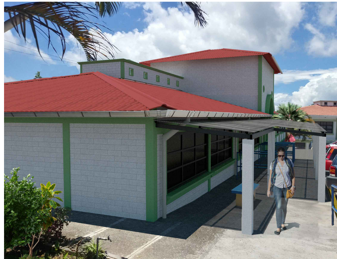
3 FOTOMONTAJE - VISTA LATERAL IZQUIERDA TECHO EN ATENCIÓN AL PÚBLICO EDIFICIO N°3
