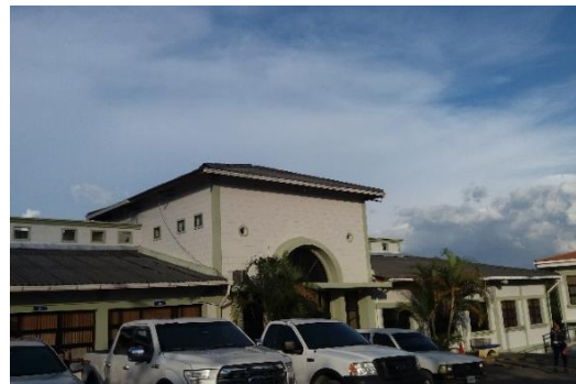
Fotografía No. 6. Edificio N°3
