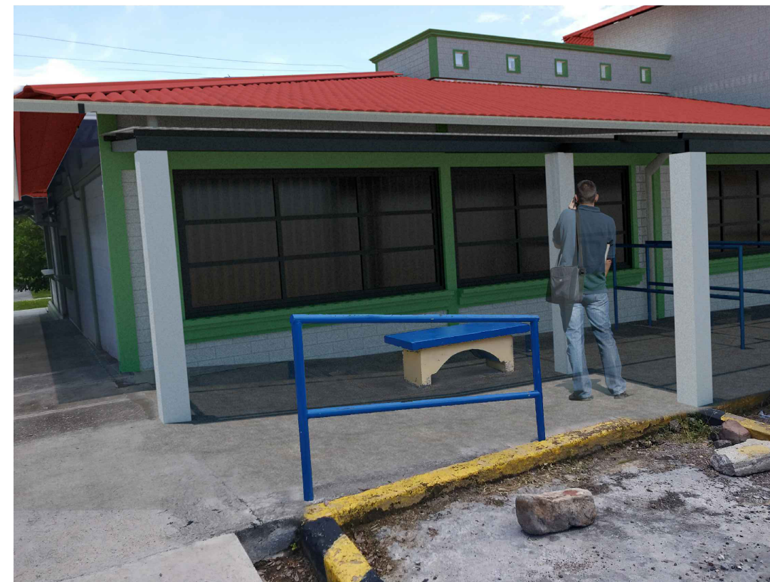
4 FOTOMONTAJE - VISTA PARCIAL TECHO EN ATENCIÓN AL PÚBLICO EDIFICIO N°3
