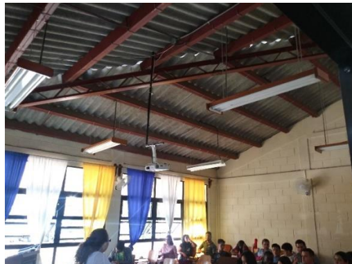
Fotografía No. 3. Aula en Edificio N° 2
