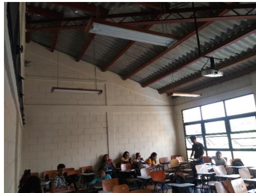
Fotografía N° 2. Aula en segundo nivel del Edificio N° 1
