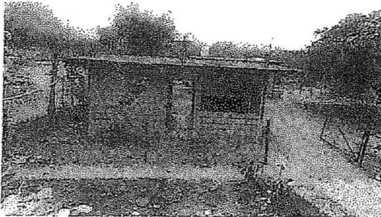
En este predio la medida dio a la mitad de la edificación
