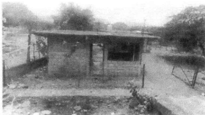
En este predio la medida dio a la mitad de la edificación
