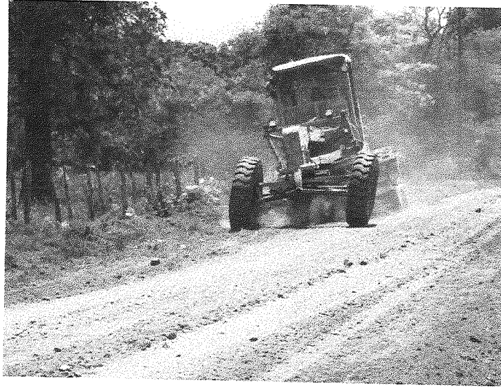
Figura 11 y 12. Reparación y Mejoramiento de Calles en Juticalpa Depto. De Olancho.
