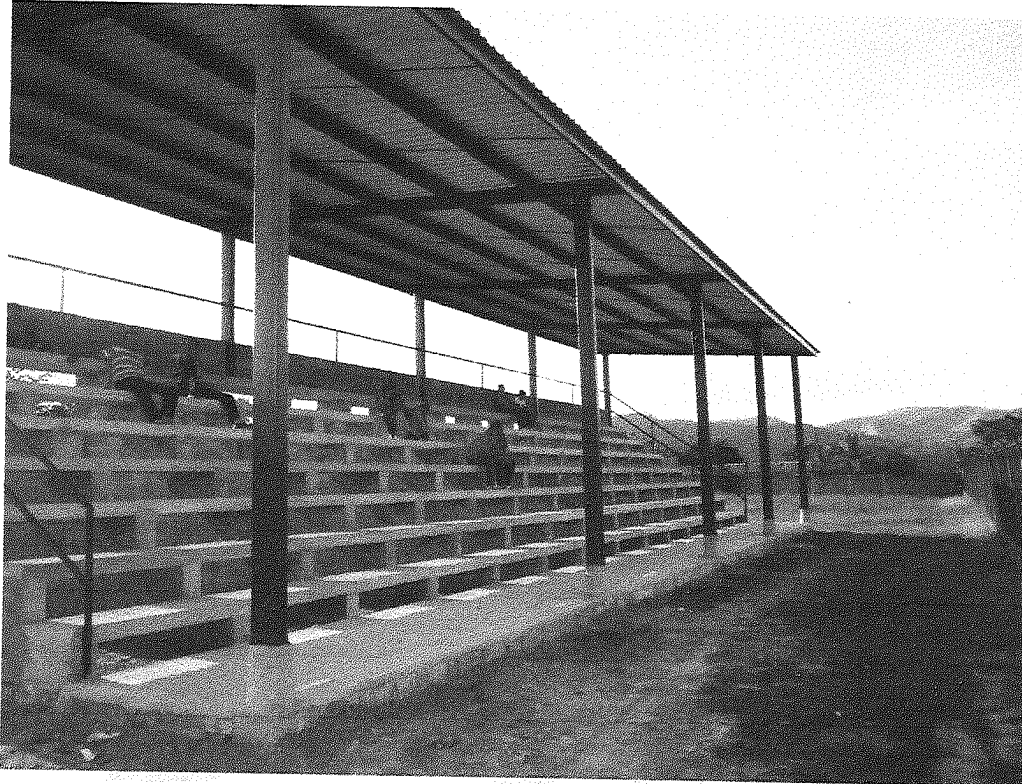
Figura 16. Construcción de graderías de estadio del Municipio de San Luis, Departamento de santa Barbará.
