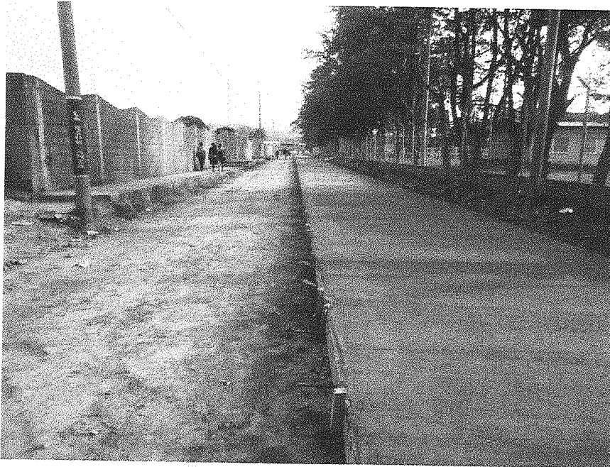
Figura 14. Pavimentación con concreto hidráulico de calle lateral del Cementerio del Municipio de La esperanza, Departamento de Intibucá.
