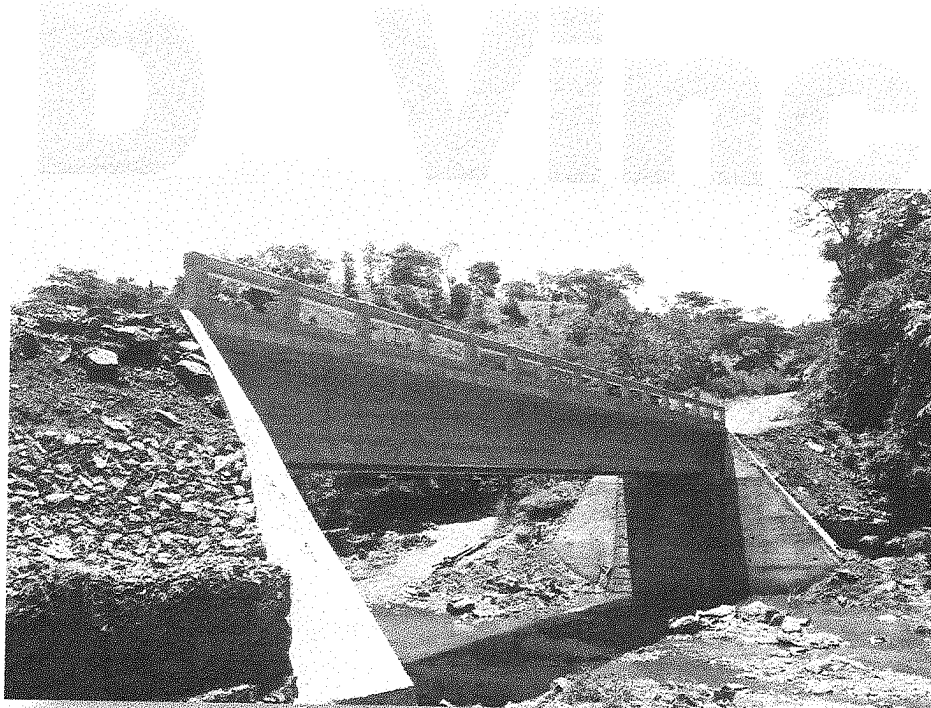
Figura 5. Construcción De Puente Sobre Rio Las Marías En El Municipio De Magdalena En El Departamento De Intibucá
