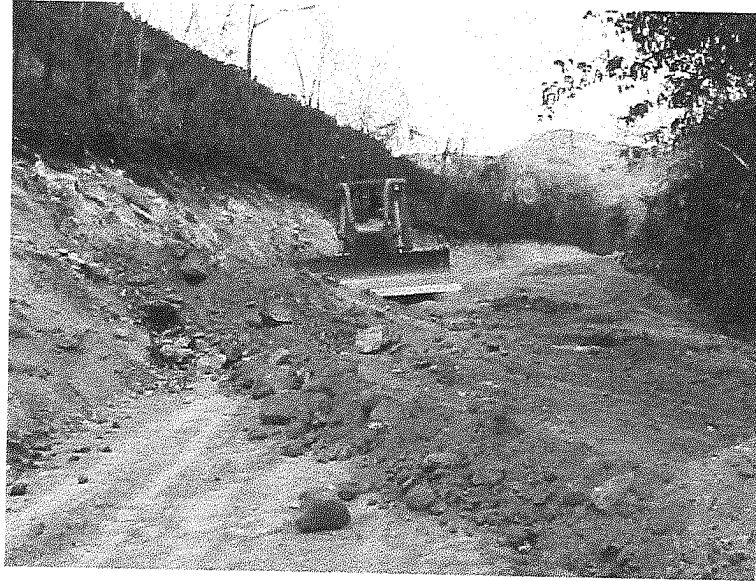
Figura 10. Supervisión de Construcción de Calle Conduce a la Comunidad de El Naranjo; Municipio de Catacamas, Departamento de Olancho
