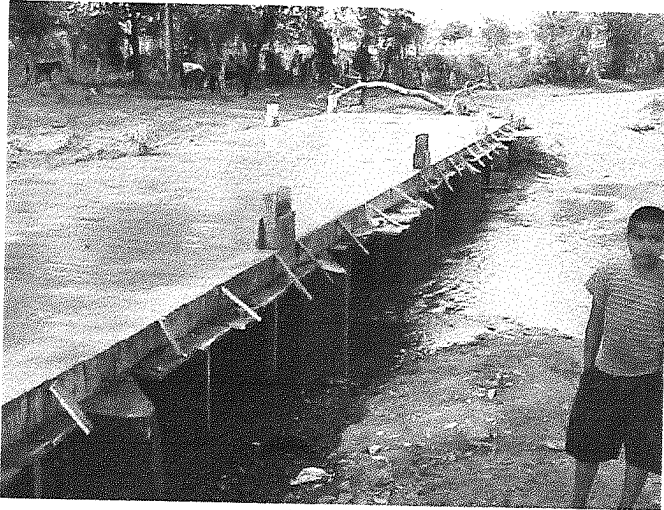
Figura 1. Supervisión de Vado sobre el rio Blanco, Catacamas Departamento de Olancho
