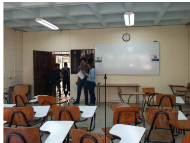
- DEMOLICIÓN DE PARED DE PANELIT - DESMONTAJE DE PUERTAS Y VENTANAS EXISTENTES
