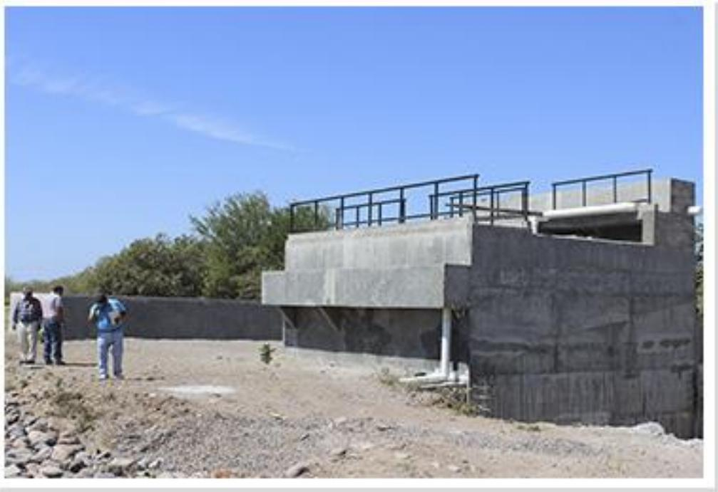
El proyecto consiste en la edificación de 6.7 kilómetros de red de alcantarillado, 356 acometidas domiciliarias, cárcamo de bombeo, caseta, reactor anaeróbico y un lecho de secado.
