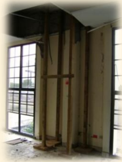
“Apuntalamiento con Estructuras de madera para soporte de vigas y columnas existentes del Palacio de Justicia de San Pedro Sula, Departamento de Cortes”
