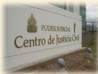
“Construcción de Monolito para Identificación Exterior del Centro de Justicia Civil”
