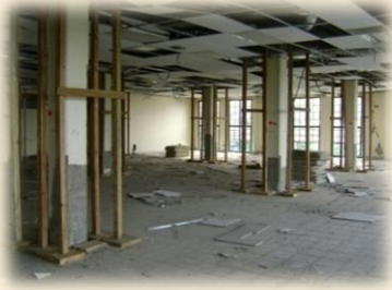
“Apuntalamiento con Estructuras de madera para soporte de vigas y columnas existentes del Palacio de Justicia de San Pedro Sula, Departamento de Cortes”
