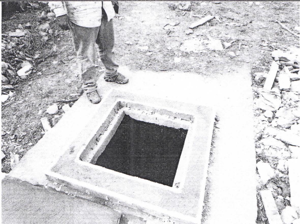
Figure 3 Se realizo la construcción de casquete para pozo existente, al igual que tapadera.
