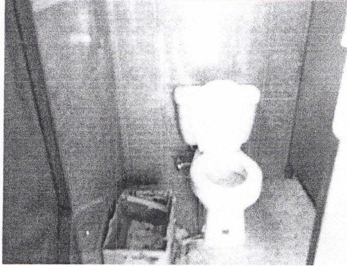
Figure 4 Servicios sanitarios Probados
