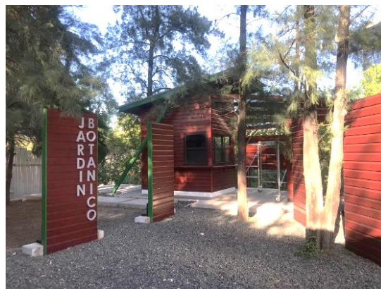
Construcción de acceso al jardín botánico, como obra de compensación.
