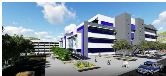
Vista noroeste del Edificio B1
