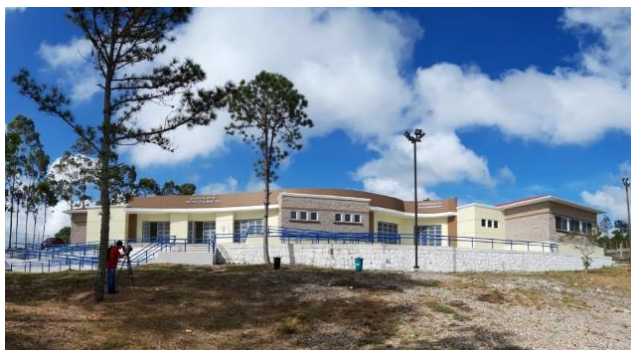
Vista fachada principal de Laboratorios de Ciencias Básicas y Planta Piloto de Innovación Alimentaria
