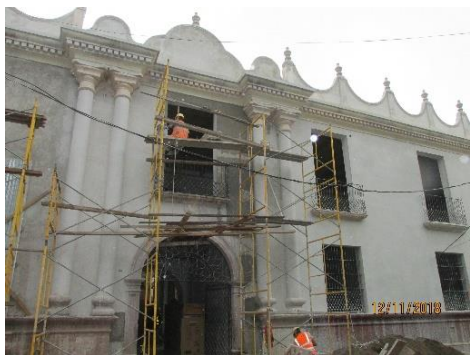
Vista fachada principal del Edificio, ubicado frente al parque de La Merced, Calle Bolívar, Tegucigalpa, M.D.C.
