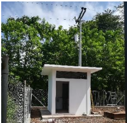
Caseta de Vigilancia
