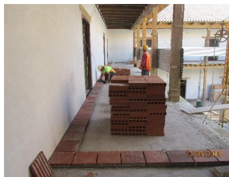
Cambio de piso en pasillo de segundo nivel
