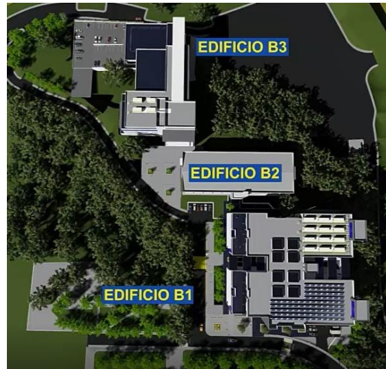
Conjunto Edificio Facultad de Ingeniería
