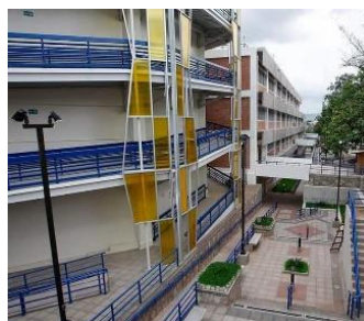
Vista de fachada y plaza norte del Edificio C3
