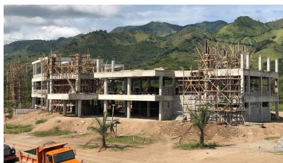
Avance de obra Edificio Administrativo
