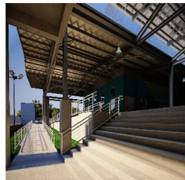
Rampa y gradas de acceso
