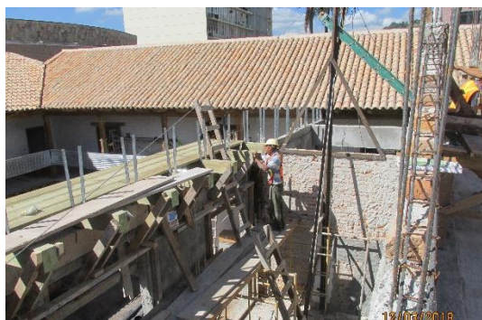
Avance de obra en cambio de techo en fachada este
