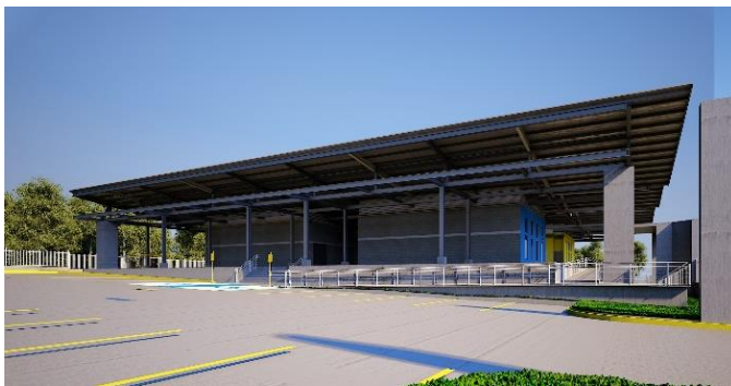
Vista de fachada lateral desde estacionamiento
