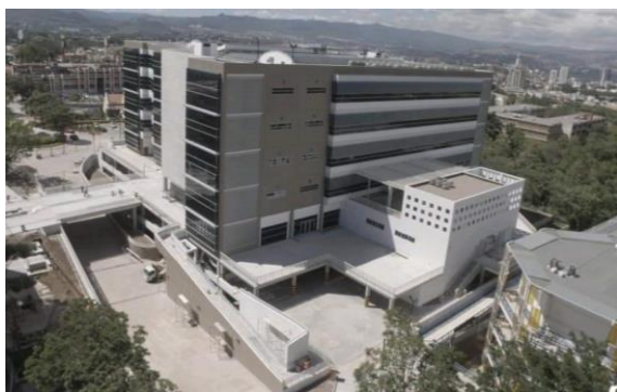
Vista aérea noreste del Edificio 1847
