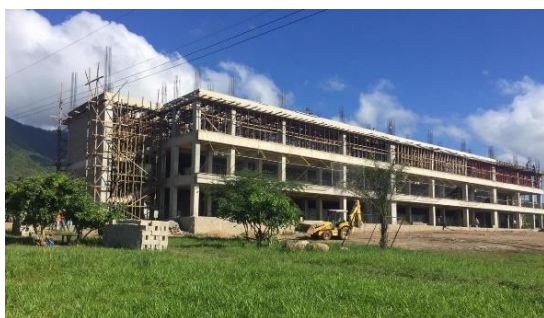
Avance de obra Edificio de Aulas No. 1
