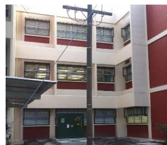
Fachada norte Edificio No. 3
