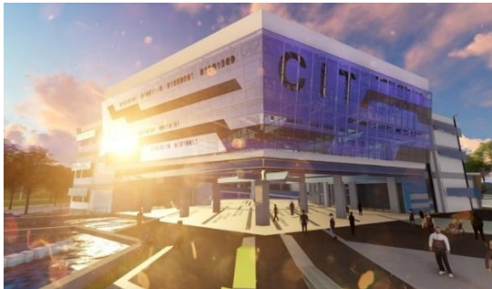
Vista exterior del Edificio E1 y la plaza de acceso
