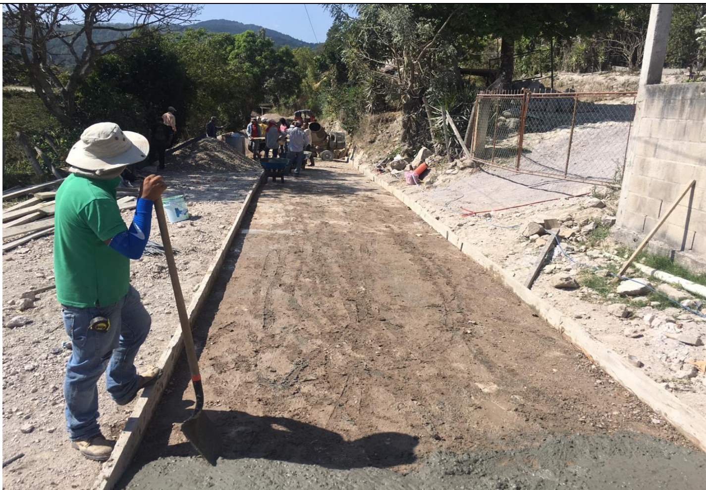
Proceso de Fundición.
