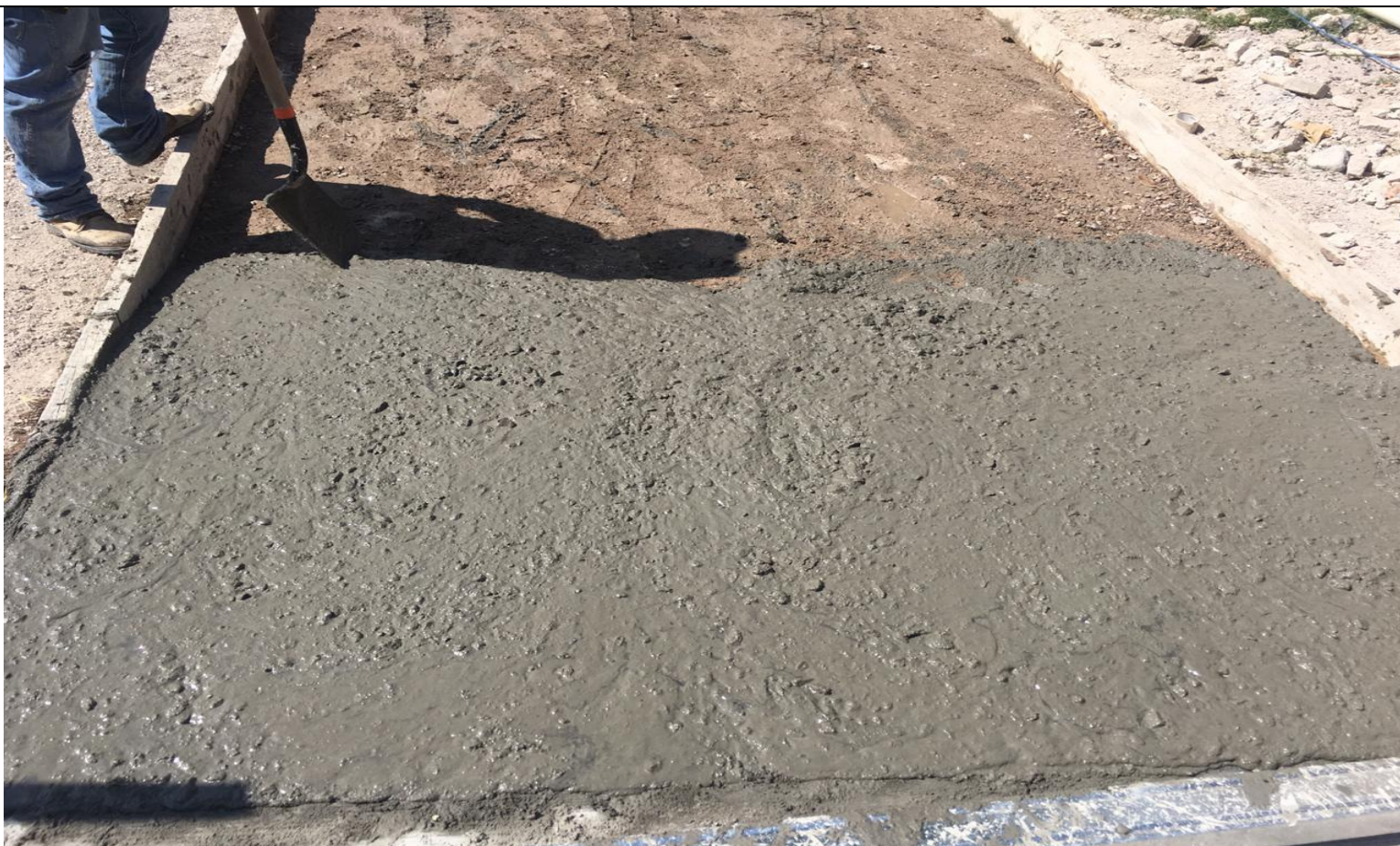
Proceso de Fundición de Concreto.
