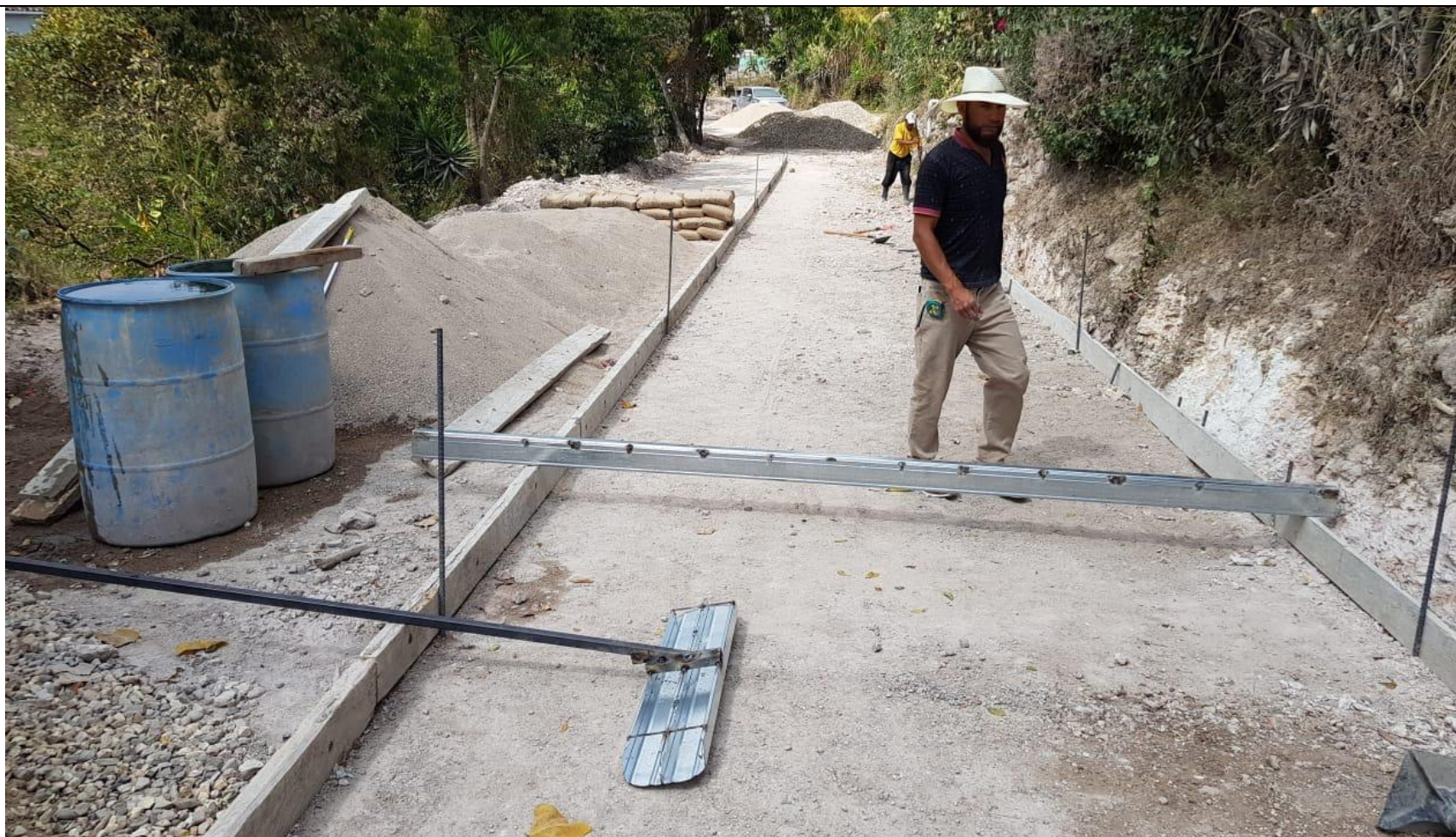
Proceso de Encofrado.
