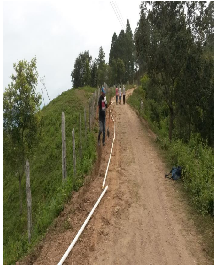
Instalación de red de distribución de sistema de agua potable comunidad la loma
