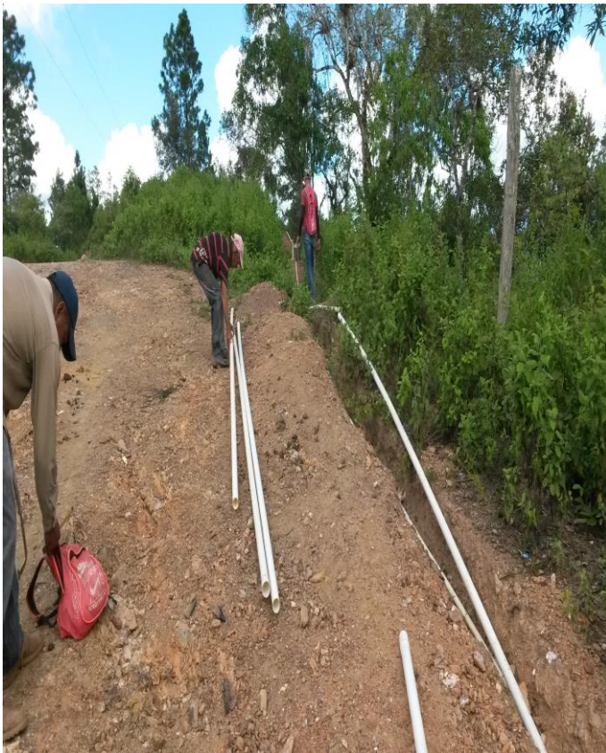
Instalación de red de distribución de sistema de agua potable comunidad la loma
