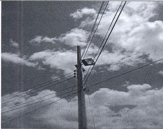
Lámparas tipo reflector instaladas en poste de concreto.
