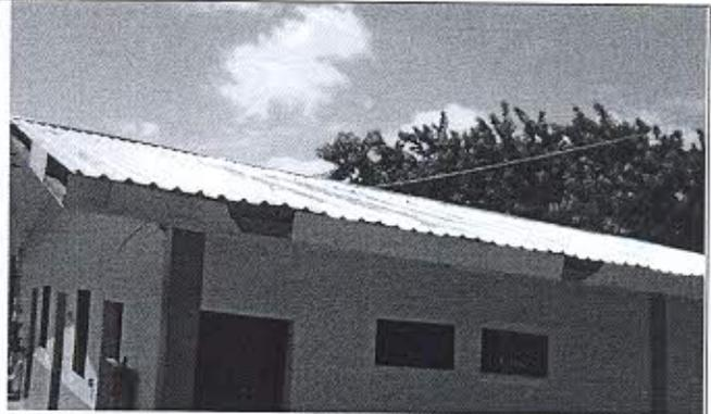
VISTA LATERAL IZQUIERDA, SE DESMONTO TODO LA CUBIERTA DE ASBESTO Y SE INSTALO LA CUBIERTA DE ALUZINC.
