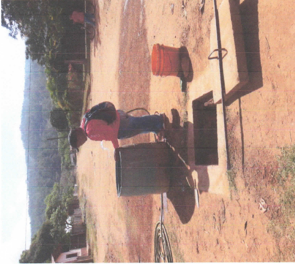
Pruebas de conducción y limpieza de sistema de alcantarillado
