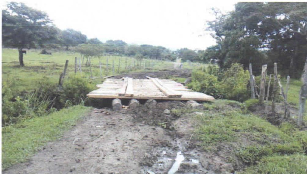
Se utilizó madera para el firme del puente para que fuese transitado con facilidad.
