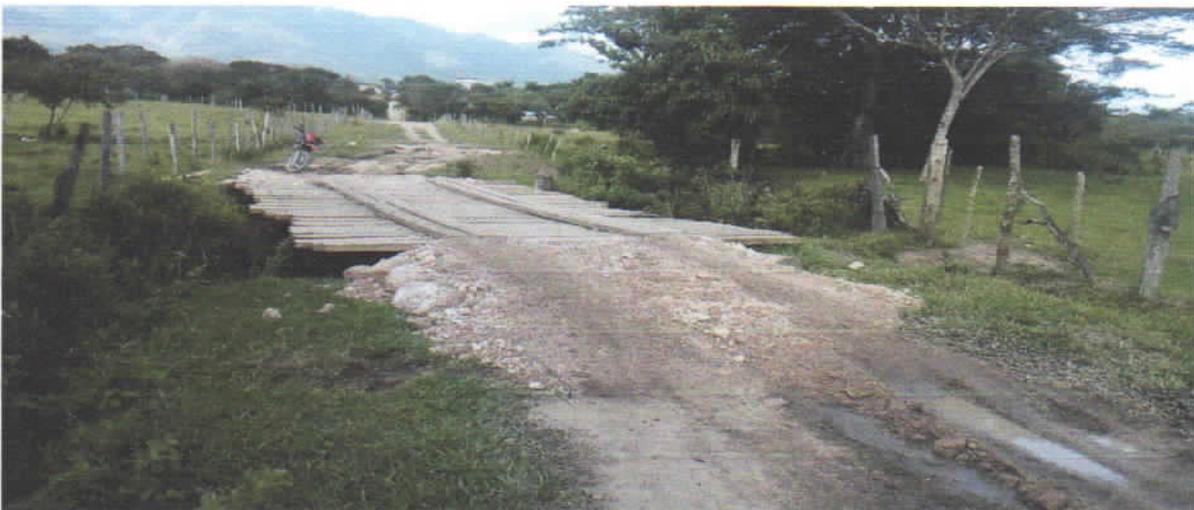
Balastre utilizado para anivelar el paso en el puente y listo para ser transitado sin ningún problema.
