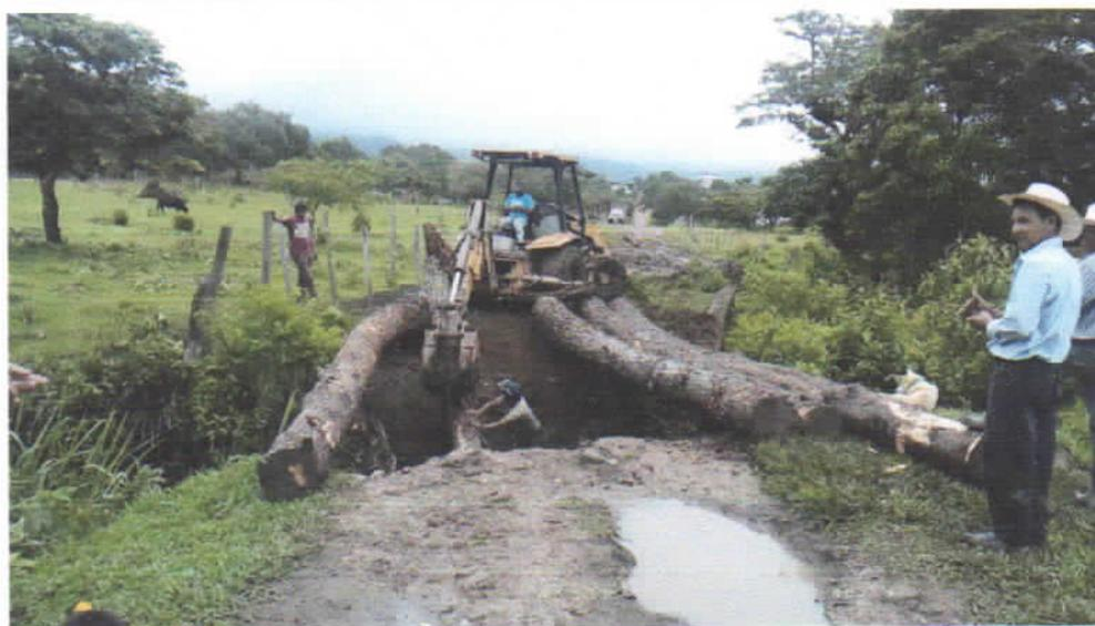
Se inspecciona la colocación de bigas en la falla con maquinaria ya que por el peso que estas tienen no se pueden trasladar con personas.
