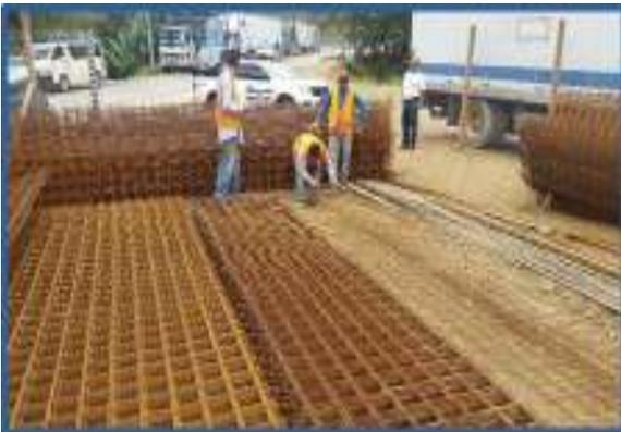
Malla Electro soldada para fachada de muro mecánicamente estabilizado en Falla Est. +000
