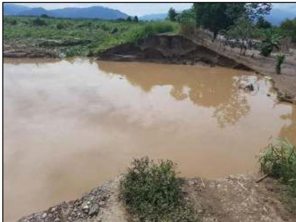
Cierre de boquetes, reconstrucción y sobreelevación de bordo margen derecha del Río Chamelecón, sector Guarumas II, Villanueva, Cortes
