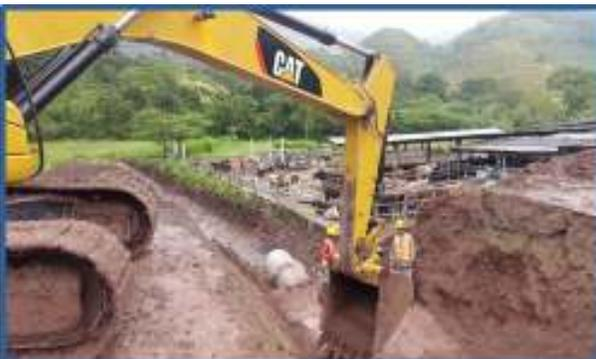
Instalación de Tubería TCR de 36" en Est. 120+013
