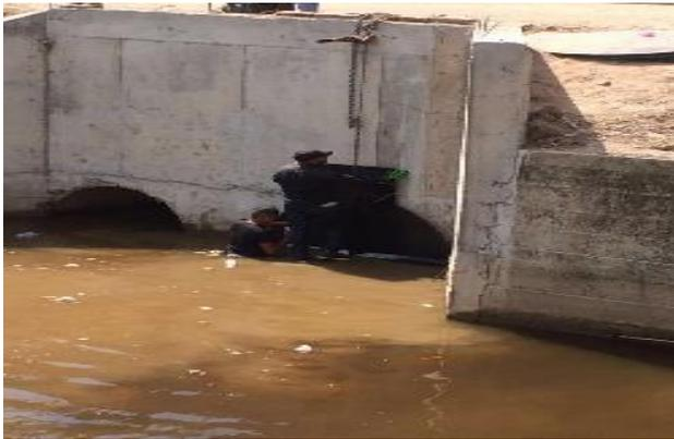
Construcción de alcantarilla de paso doble de 60" pulgadas de diámetro en tramo carretero, sector Tapón de Los Oros-La Puntilla.
