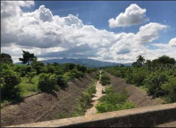
Remoción de la Capa vegetal y control de arbusto en sección hidráulica del Canal Chotepe .
