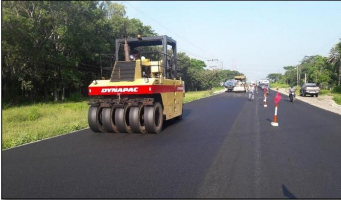
Colocación de primera capa de asfalto en el tramo Júcaro Galán – Santa Elena de 35.85 kilómetros
