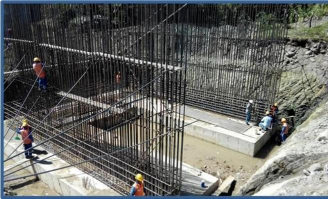
En el puente Chiquito se avanza en el armado del acero de refuerzo del estribo de entrada del lado derecho.
