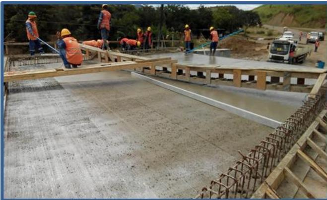
Fundición de la losa derecha del puente chocolate.
