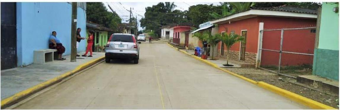
Detalló que en el barrio El Cementerio, en el Municipio de San Francisco de la Paz se realizó la construcción de tres tramos de pavimentación de 250 metros lineales, marcaje de calle, relleno, fundición de bordillos y compactación de base.
