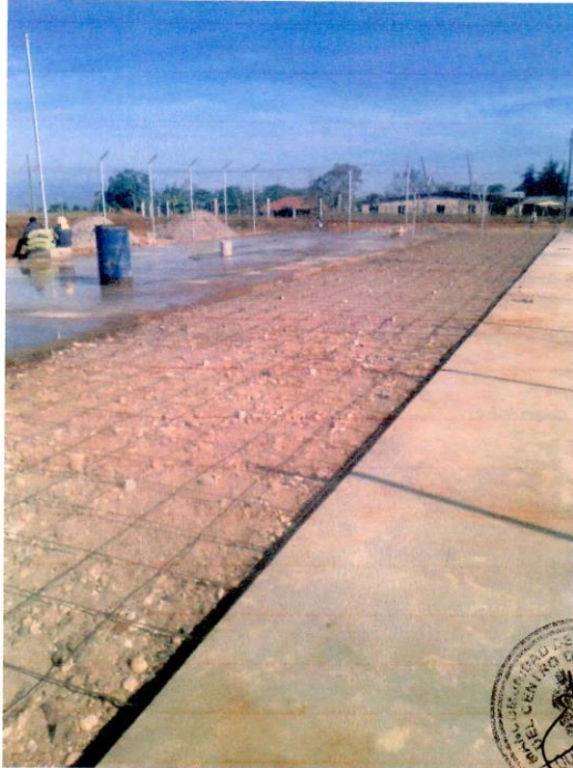
SE OBSERVA ACERO POR TEMPERATURA Y LOSA.
