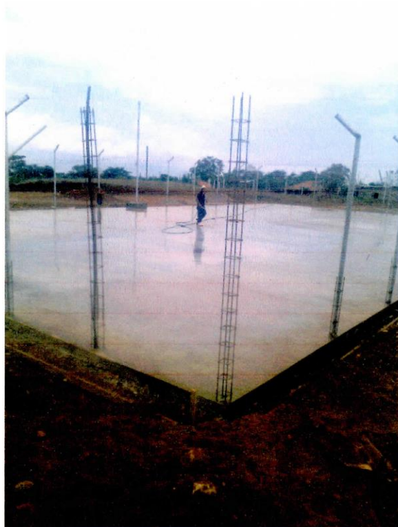
SE OBSERVA LOSA TERMINADA, CASTILLOS, CURADO DE LOSA, TUBO HG
