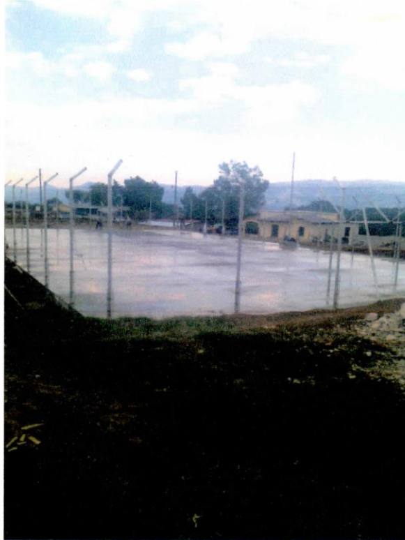
LISTO PARA INSTALAR LA MALLA CICLON.
