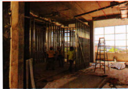
Instalación de paredes de durock en Quinto Nivel.
