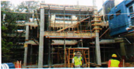
Construcción estructura de lobby del edificio
