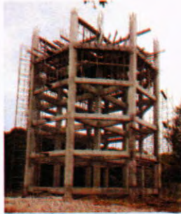
Vista del avance constructivo de la estructura del Tanque de Abastecimiento de Agua; 01-11-2017
