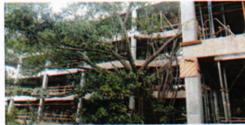
Vista frontal de estructura del edificio
