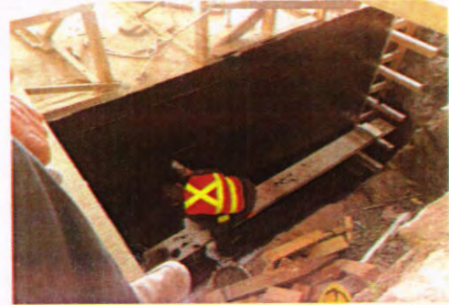
Se termino la impermeabilizacion de la cisterna: Igol denso en el exterior y Admix M-1 en el interior
