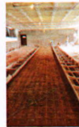
Armados de firmes
