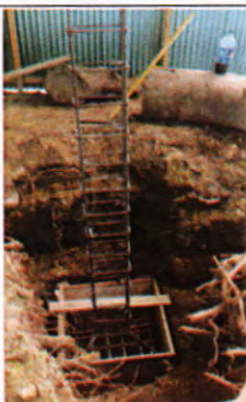
Armado y encofrado de zapata aislada y columna
