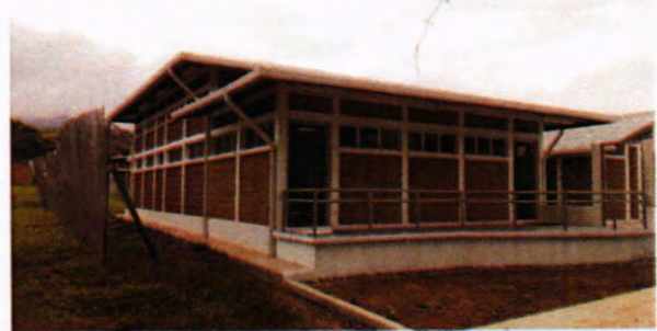
Vista de fachada Norte y Este de Módulo de Desinfección Personal (30-10-2017)
