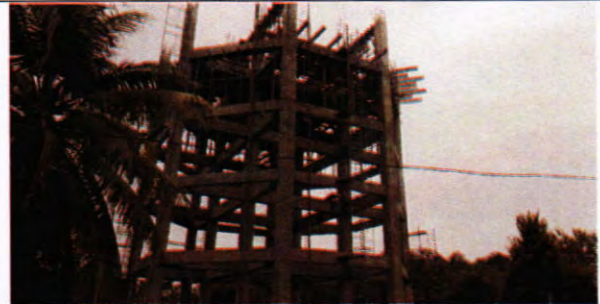
Vista de encofrado de vigas del nivel 5 y columnas de concreto entre nivel 4 y 5; 01-11-2017
