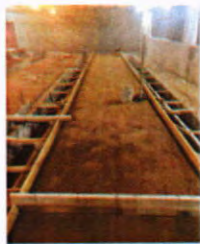
Compactación para firmes, Clínica Operatoria
