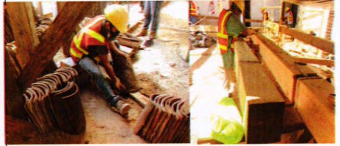
Se esta trabajando en la preparacion de la teja para volverla a instalar y en el tallado de las columnas de madera.
