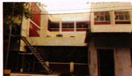
Fachada posterior del edificio donde se remodelan los laboratorios
