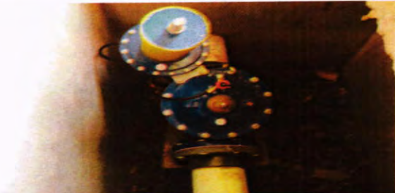
VALVULA DE ALTITUD EN PRUEBA DE FUNCIONAMIENTO LLENADO Y VACIADO DE TANQUE DE FORMA AUTOMATIZADA
