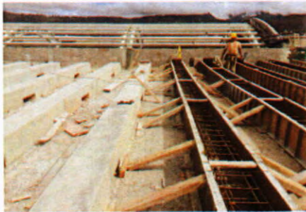
Construcción de bases de colectores solares de sistema de agua caliente.
