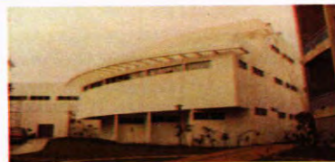
Fachada Sur, Modulo D
