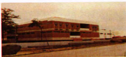
Fachada Oeste Módulo C
