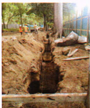
Excavación para cimentación
