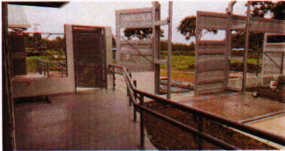
Vista de Arco de Desinfección y Portones de Granja Avícola y Granja Porcina. (30-10-2017)
