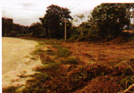
Descapote para estacionamientos provisionales
