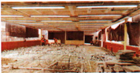
Demoliciones de piso 3era etapa
