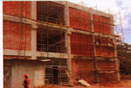
Trabajos de Limpieza y Resane en Fachada Oeste
