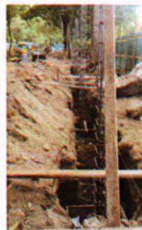
Armado de Columnas y fundición de zapatas
