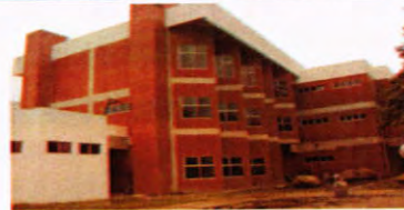
Fachada Norte, módulo B
