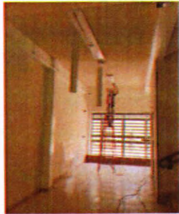
Instalación de Lámparas
