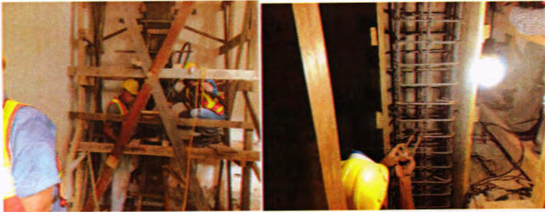
Se esta trabajando en el encofrado, armado y fundido de las estructuras de cimentacion, columnas y vigas del ala norte
