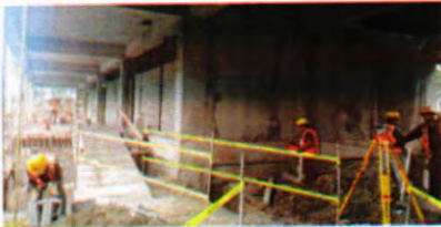
Construcción de paredes en primer nivel de aulas
