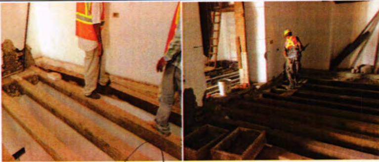
Se esta trabajando en la instalacion de los largueros de la estructura de entrepiso y en la preparacion de la argamasa
