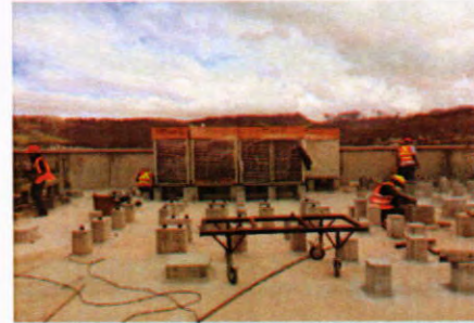
Instalación de máquinas condensadoras en Azotea.
