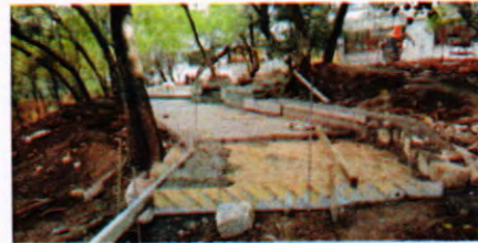
Construcción de sendero desde edificio hasta estacionamiento
