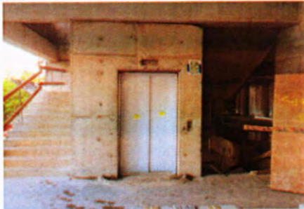
Instalación de cabinas de ascensores.
