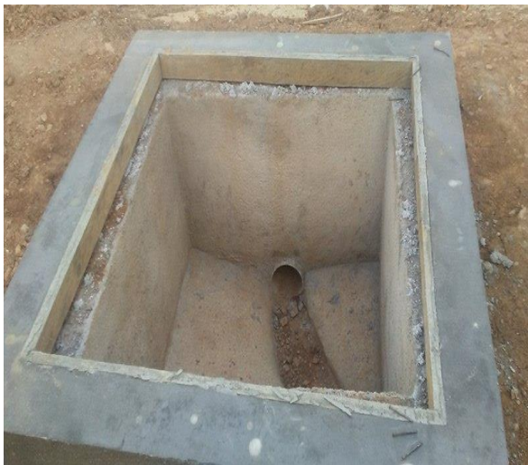
Supervisión de Cajas de Registro Terminadas Que conducen del Desarenador a las lagunas de oxidación.
