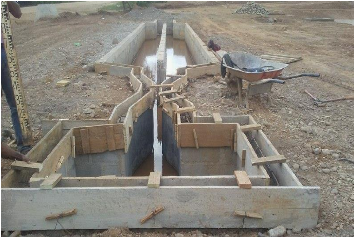
Supervisión de Cajas de Registro Terminadas Que conducen del Desarenador a las lagunas de oxidación.
