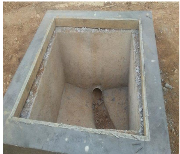
Supervisión de Cajas de Registro Terminadas Que conducen del Desarenador a las lagunas de oxidación.
