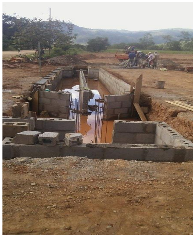
Desarenador en proceso de construcción
