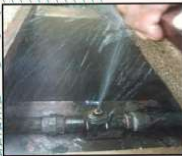
Fugas en Válvulas de limpieza
