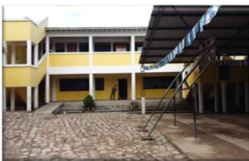
Obras civiles San Antonio de Oriente
