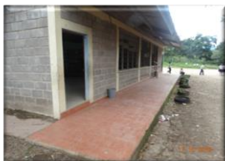
Obras civiles San Antonio de Oriente
