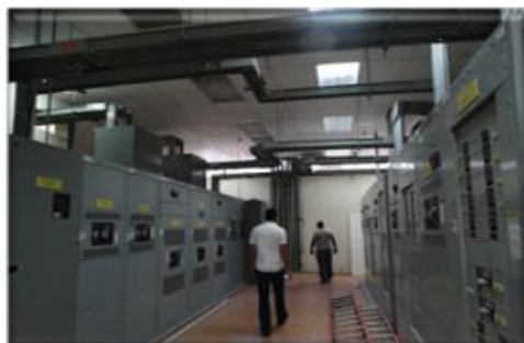
Canalización de cableado con tubería expuesta
