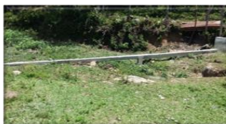
Vista del Sistema de Alcantarillado.
