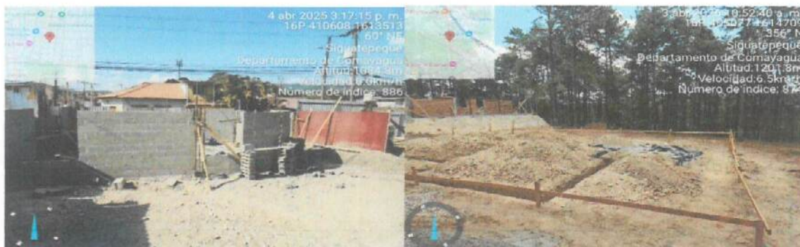
Imágenes 11 - 12: Inspecciones por permisos de construcción.
