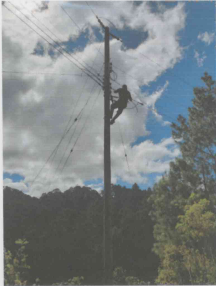
✓ Instalación de luminarias.
