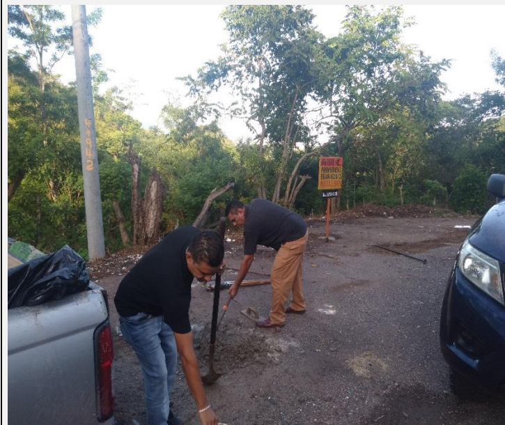
Instalación de rótulos
