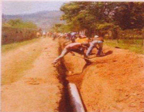
*Aterrado de Tubería con M.O. local*
