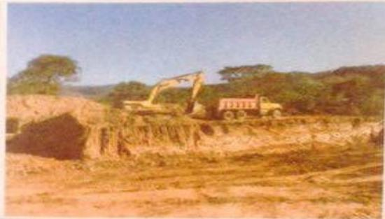
*Excavación mecanizada de las Lagunas de Oxidación.*
