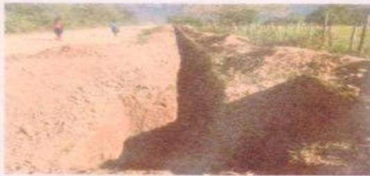
*Excavación para colector principal, a 120 m de Lagunas de Oxidación.*
