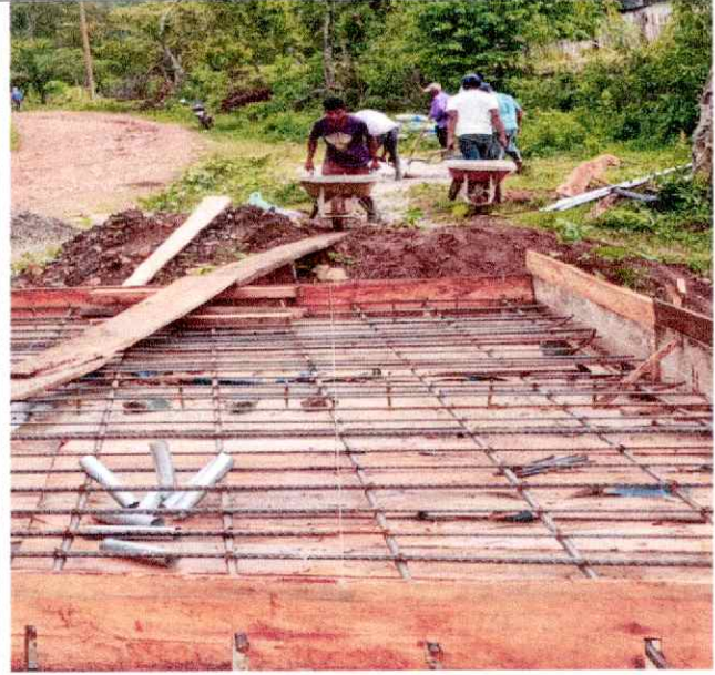
Descripción detallada: Encofrado terminado
