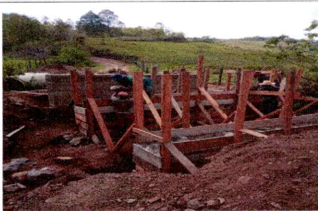
Descripción detallada: encofrado en bases
