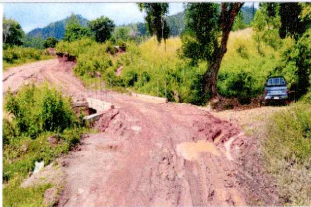
Descripción detallada: Caja puente terminada
