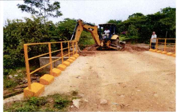
Descripción detallada: Relleno de caja puente
