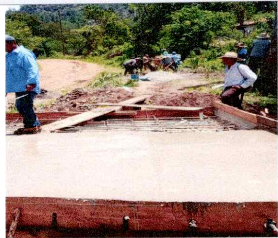
Descripción detallada: Dando acabado a losa de 22 cm
