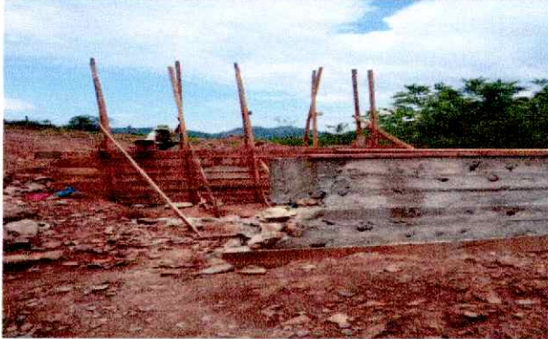
Descripción detallada: Desencofrado de base
