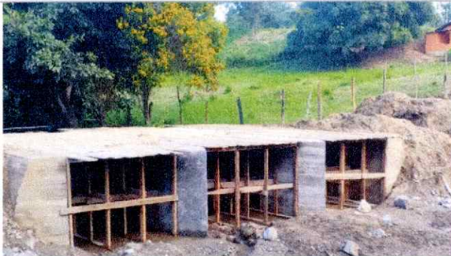
Descripción detallada: Encofrado de terraza
