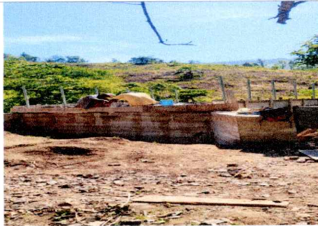
Descripción detallada: fundición de losas y pegado de tubos
