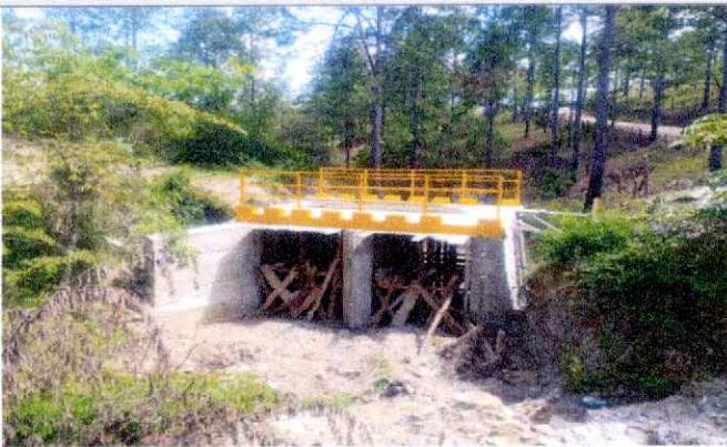
Descripción detallada: Caja puente terminada
