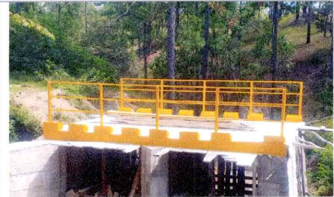
Descripción detallada: Caja puente terminada
