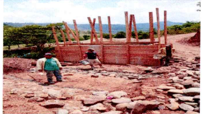
Descripción detallada: Fundiendo nueva base
