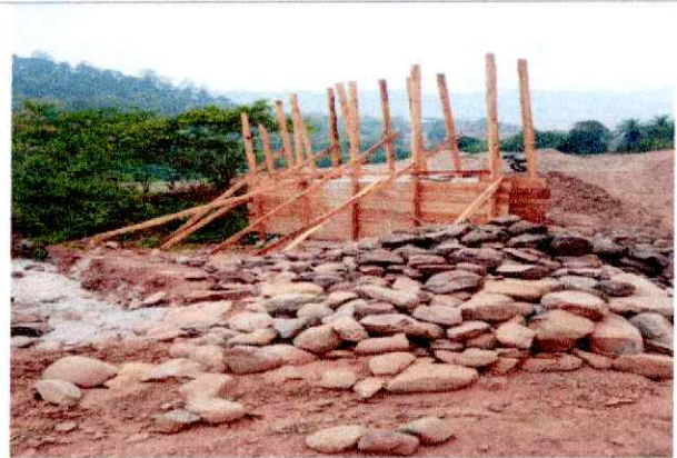
Descripción detallada: Acabado de fundición de base.
