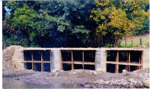
Descripción detallada: Encofrado de terraza
