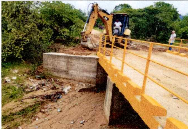
Descripción detallada: Relleno de caja puente
