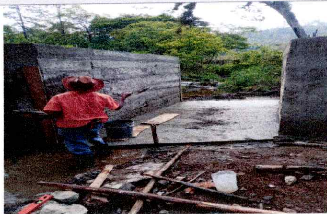
Descripción detallada: Repellando las bases
