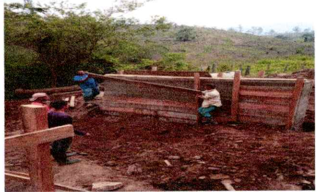
Descripción detallada: bases fundidas
