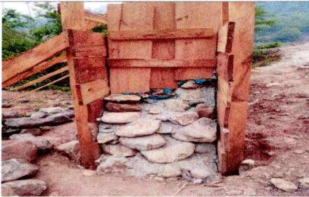
Descripción detallada: Encofrado de fundición
