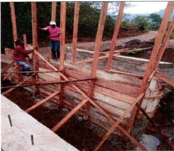
Descripción detallada: Encofrado de pilastra central
