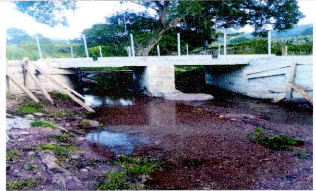
Descripción detallada: Caja puente terminada
