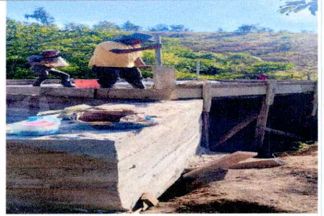
Descripción detallada: fundición de losas y pegado de tubos
