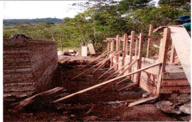
Descripción detallada: encofrado en bases
