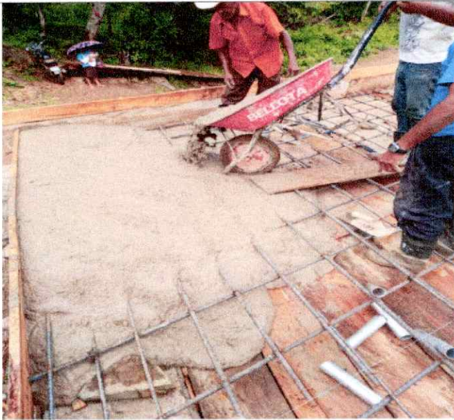
Descripción detallada: Fundición de losa
