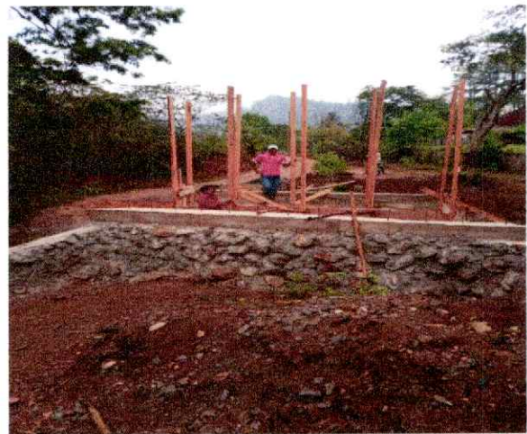
Descripción detallada: Encofrado de pilastra terminado
