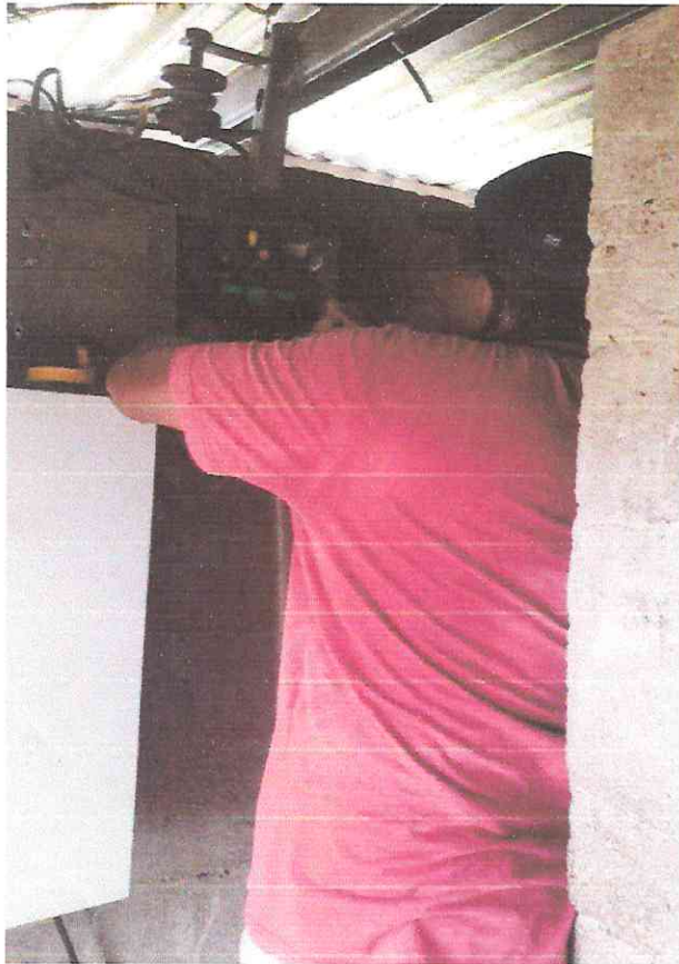
Instalación de brake nuevo
