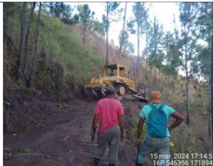
Trabajo de reparación y limpieza de camino El Suyatal
