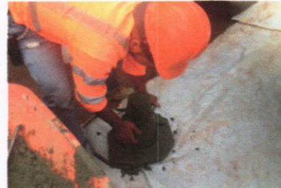
Prueba de revenimiento para fundiciones de cubos de elevadores
