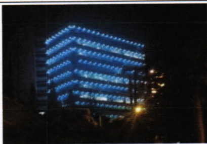
Vista oeste del edificio.
