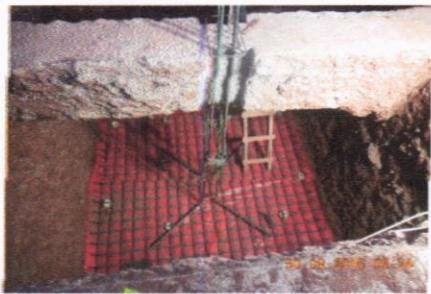
Armado de Zapatas y Columnas
