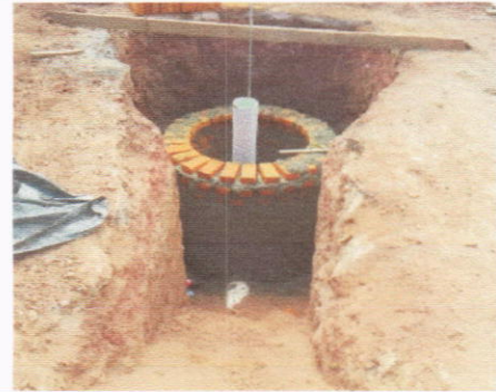
Construcción de pozo de inspección.
