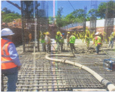
Fundición de zapata.
