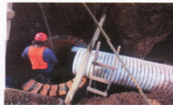
Trabaja en Pozo de Aguas Lluvias
