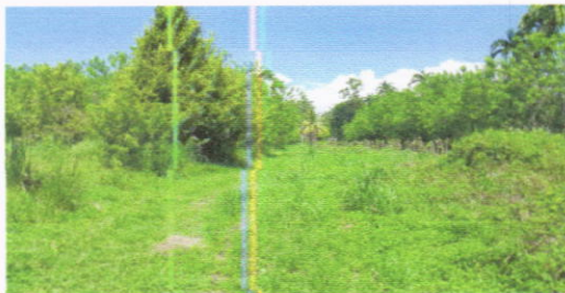
Vista del sitio seleccionado para la construcción del Tanque de Almacenamiento de Agua de 200,000 galones
