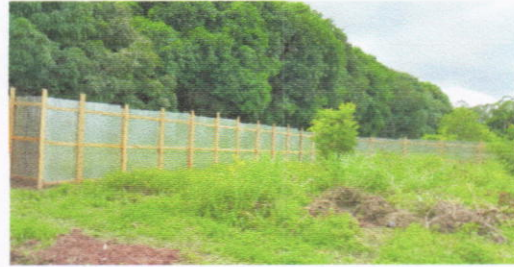
Construcción del cerco provisional perimetral del Proyecto
