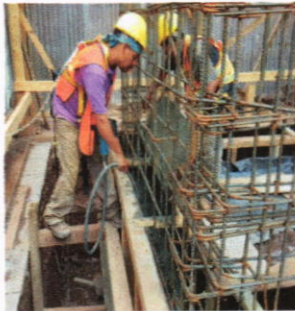
Vista de aplicación del vibrador en fundición de paredes en cubo de elevador
