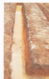
Excavación de Zanjos de la Cimentación del Modulo de Desinfección Personal
