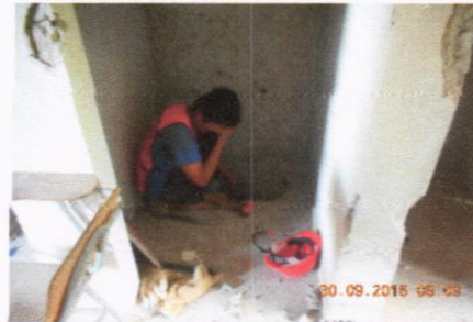
Demolición de Pasante en Losa para Construcción de Columnas Nuevas
