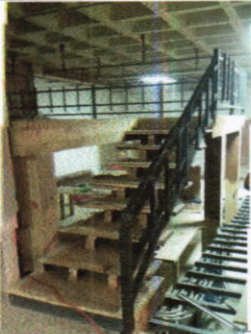
Gradas hacia el mezzanine, proceso de lijado previo aplicar esmalte.
