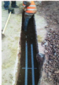
Colocación de tubería eléctrica y compactación de zanja para línea de media tensión
