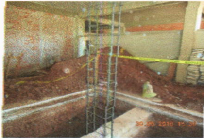
Armado de Columnas
