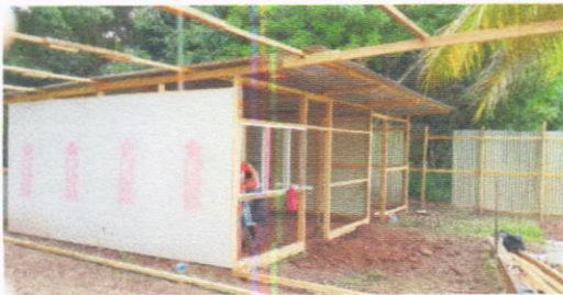
Construcción de oficinas temporales del Contratista y Supervisión
