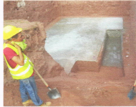
Plantilla de concreto pobre para losa de cisterna.
