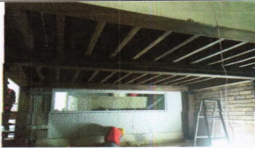
Vista nivel inferior sala multimedia, al fondo cabina de edicion
