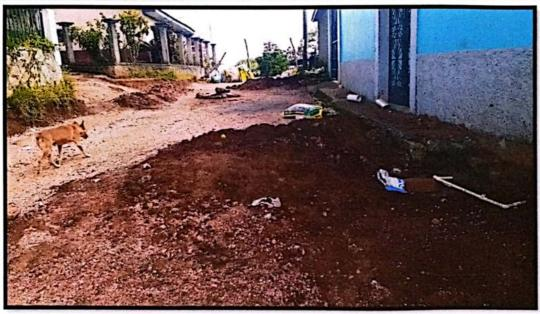
2. Se realiza excavacion y conformacion de la calle
