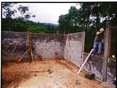
FUNDICION DE COLUMNAS CONCRETO
