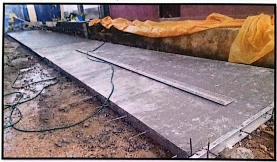
4. Se realiza fundido de pavimento, el cual se realiza con material requerido
