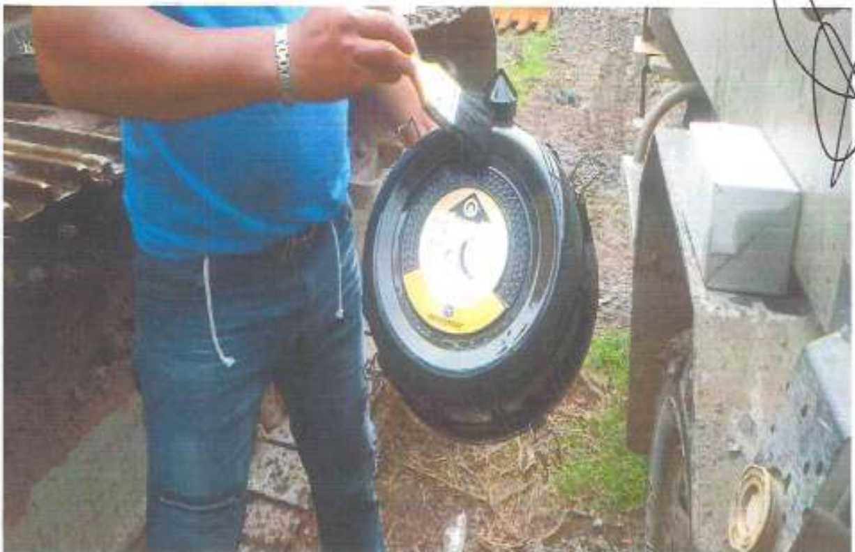
Limpieza de la tapadera del depurador para la instalación del filtro de aire.
