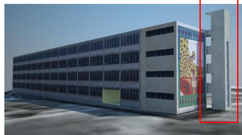
Ubicación de Elevador en Edificio A1. Ciencias
