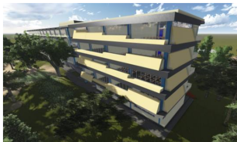
Vista noreste del edificio, con área total de 3,310 m 2 distribuidos en cuatro niveles de aulas y un nivel de oficinas
