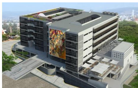
Vista aérea del edificio.
