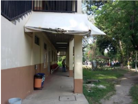
Vista Exterior del edificio
