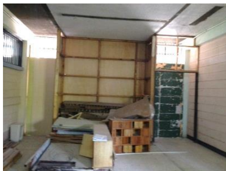
Vista Interior espacio para sala de espera y acceso al laboratorio
