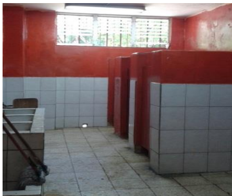
Servicio sanitario de hombres en Edificio No.1
