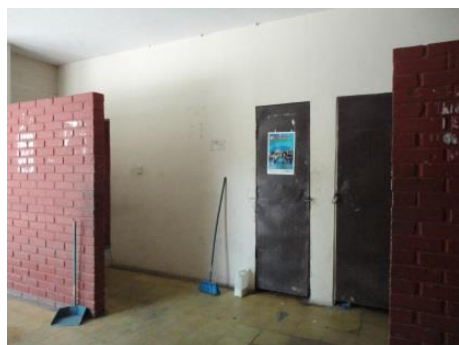
Acceso, cuarto eléctrico y de aseo.
