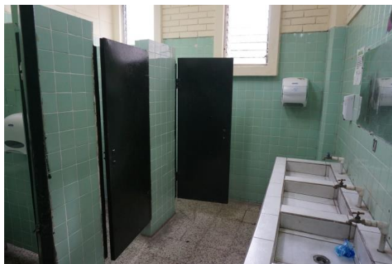
Servicios sanitarios Edificio No.2
