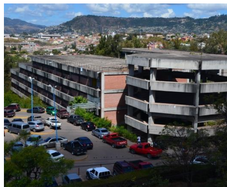
Situación actual del edificio C3
