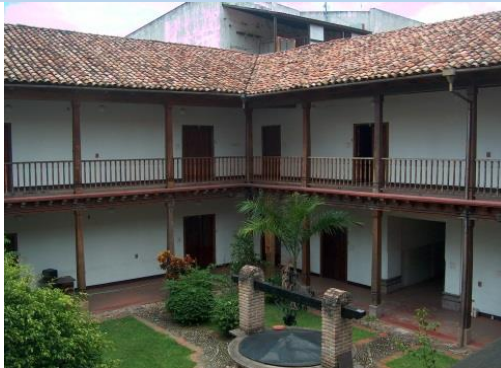
Vista desde el patio interno del edificio
