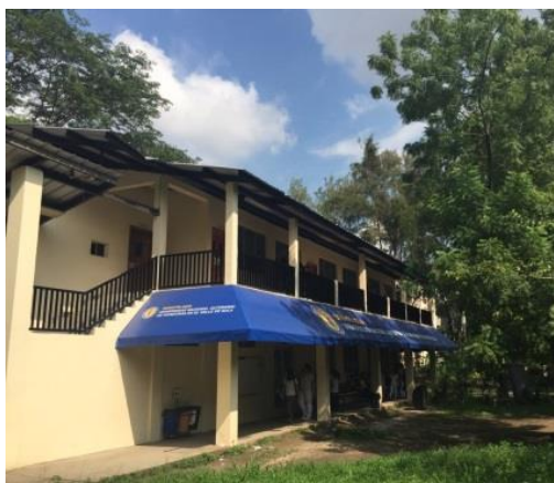
Vista Exterior del edificio
