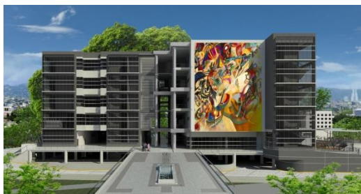
Rampa peatonal de acceso al Edificio 1847, Edificio de Aulas y Comedor Universitario.
