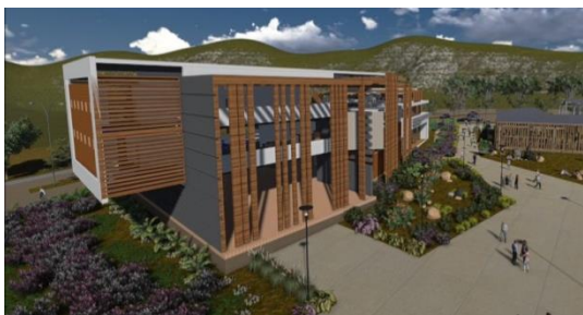
Edificio Administrativo, área 2,703.27m 2 .
