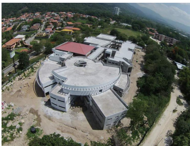
Vista aérea en la que se observa el proceso constructivo
