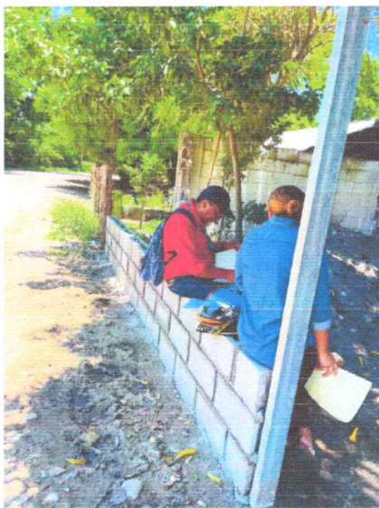
Supervisando construcción y revisando documento
