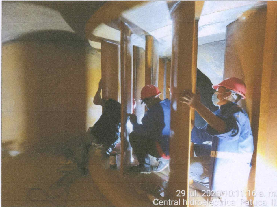
Aplicación de pintura para acabado final de los alabes fijos.
