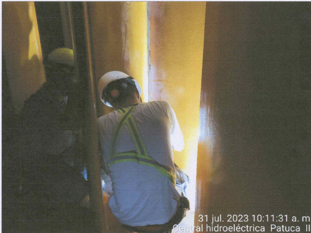
Revisión con personal de supervisión eléctrica de los trabajos en los alabes móviles de la unidad espiral No. 1.
