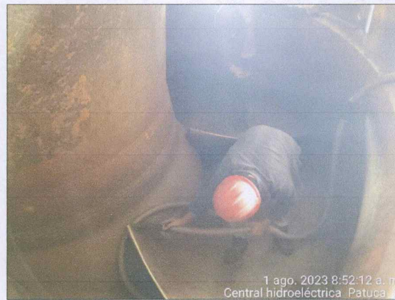
Revisión y limpieza final de la unidad espiral No. 1.
