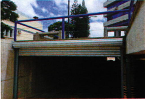
Instalación de cortinas metálicas en Sótano.
