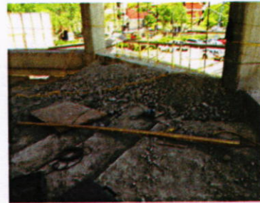
Demolicion de Parasoles del Auditorio
