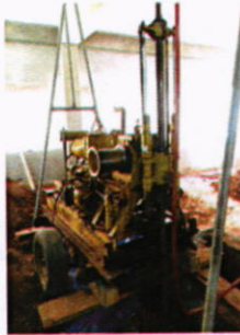
Pruebas de Suelo realizadas en el interior del Edificio
