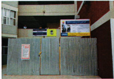
Ubicación de rótulo sobre cerco de lámina del edificio F1
