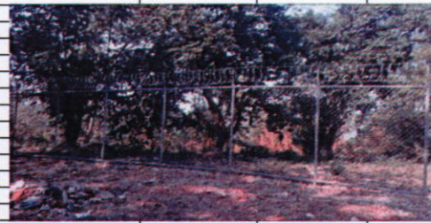
Cercos perimetral terminado terreno este
