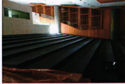
Instalación de alfombra en Auditorio.
