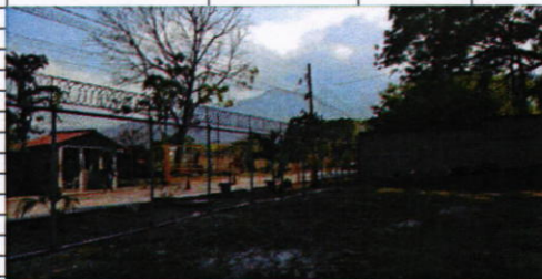
Cercos perimetral Terreno Sur Col. El Pedregal
