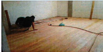
Piso de Madera en laboratorio sensorial, módulo C, 1er nivel
