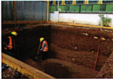
Vista de excavación adicional del fondo de cubo para elevador en edificio A1, realizada bajo el nivel de desplante de zapata
