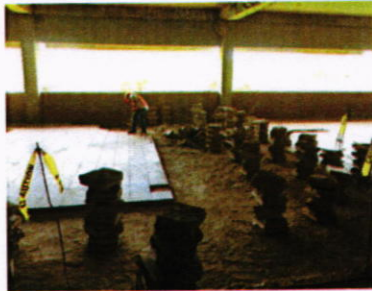
Demolición de Piso de Granito
