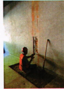
Demolición de pared para construcción de columna nueva
