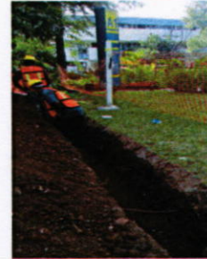
Excavación de zanjos para línea de media tensión hacia el edificio A1
