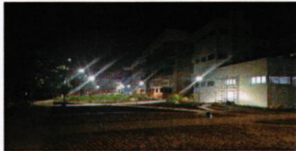
Obras exteriores e iluminación, Módulo A
