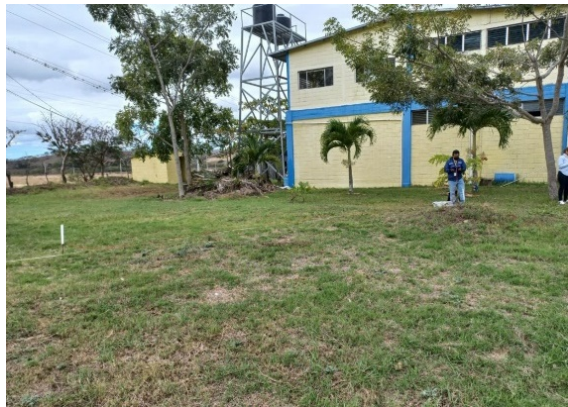
Perfil 1. Área cercana al edificio de aulas, orientado de noroeste a sureste.
