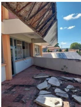
Vista lateral de parasol, con mortero desprendido y estructura interna
