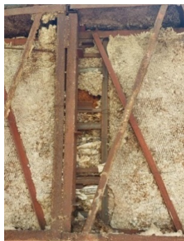
Vista lateral de parasol, con mortero desprendido y estructura interna
