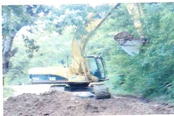
EXCAVADORA CAT 320CL
