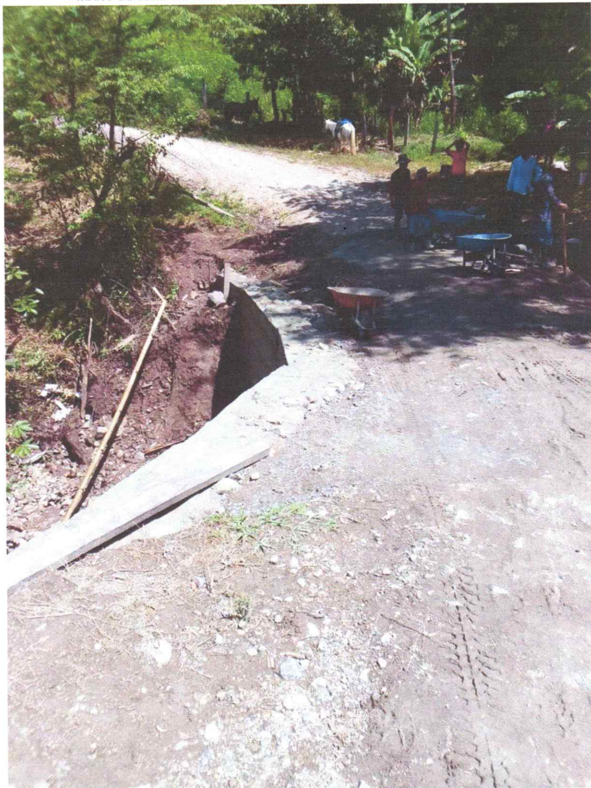
MANO DE OBRA TRABAJANDO EN LA ALCANTARILLA DE SANTA CRUZ
