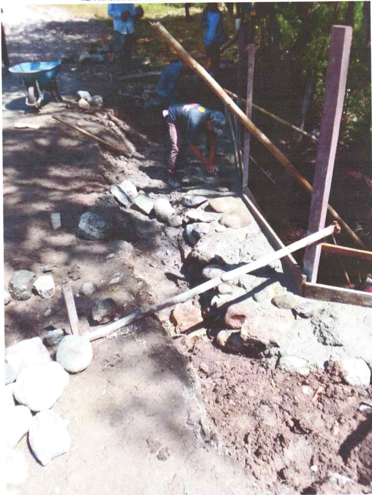
REPARACION DE ALCANTARILLA EN SANTA CRUZ
