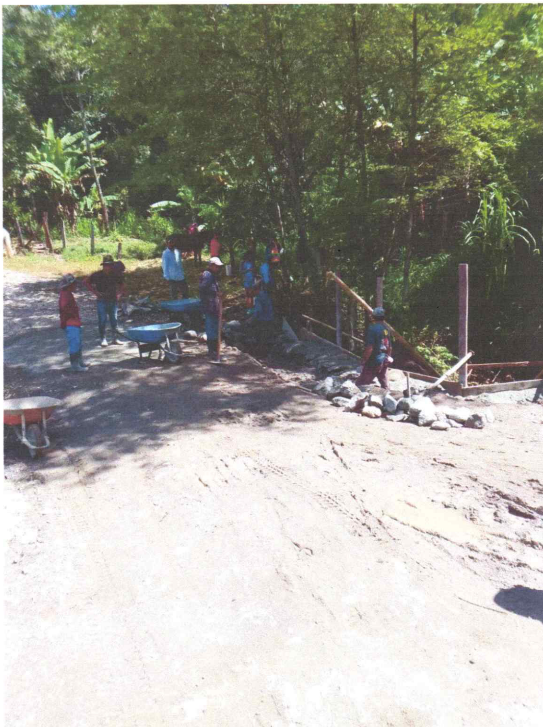
MANO DE OBRA TRABAJANDO EN LABORES REPARACIÓN
