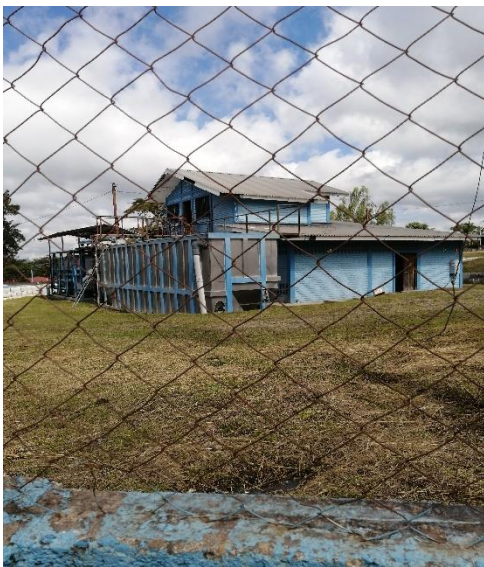
Imagen No.26: Aguas de Siguatepeque, planta de abastecimiento de agua en la zona.
