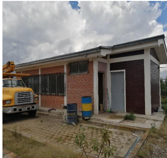
Imagen 8: Sala de Control
