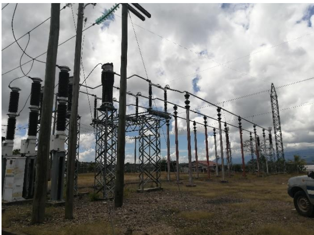
Imágenes 3 y 4: Bahía de 138kV y área donde será ampliada dicha bahía.
