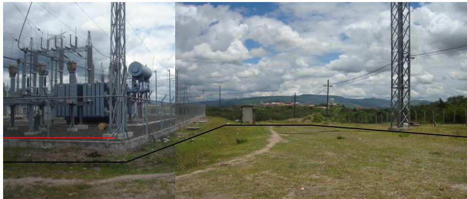
2. Área para ampliación, Subestación Toncontín.
