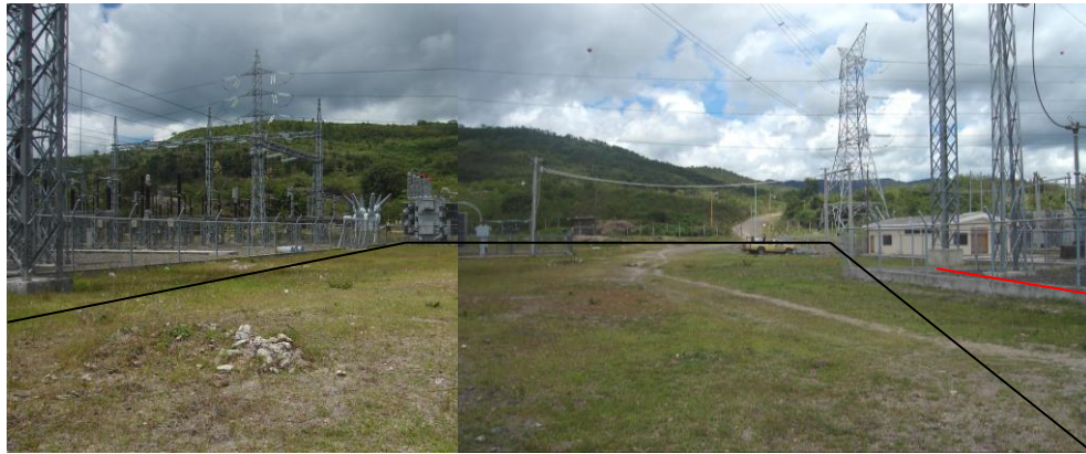
1. Área para ampliación, Subestación Toncontín.
